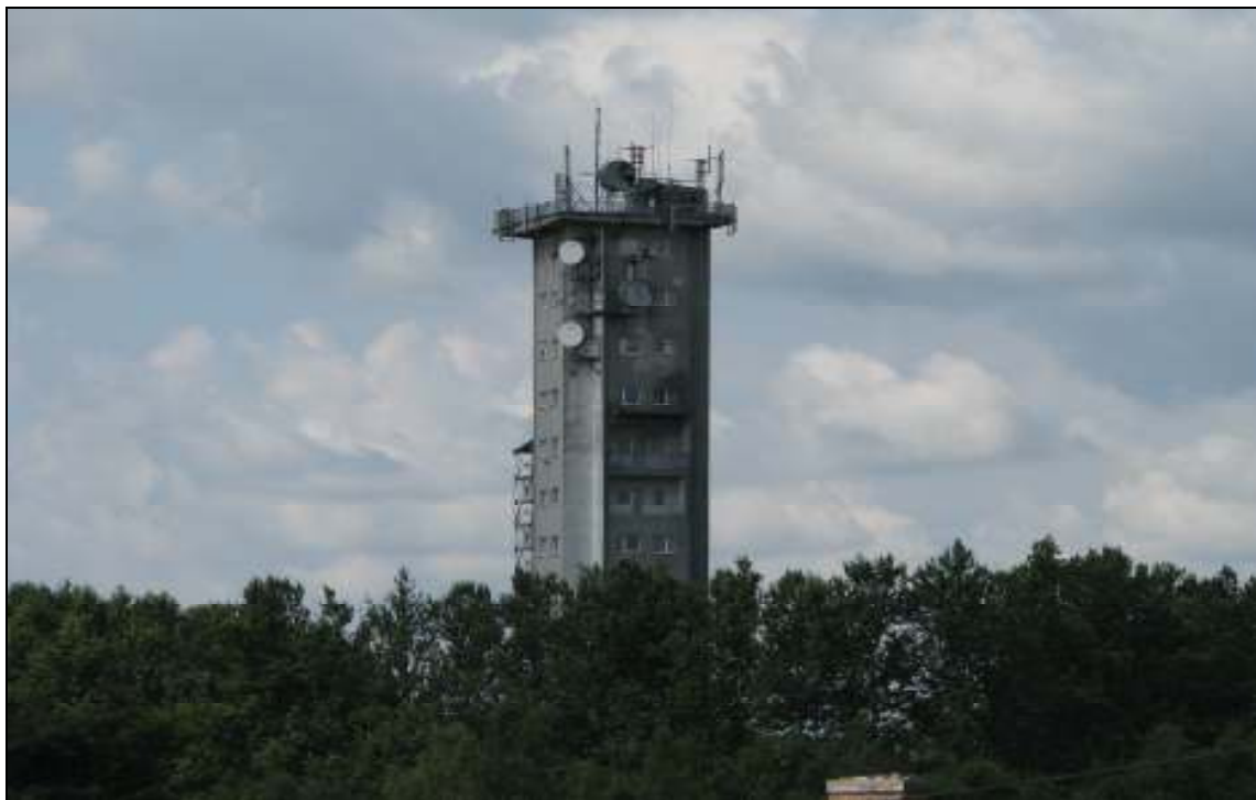
Fot. 4. Wieża radiokomunikacyjna SLR NIEGOWA
