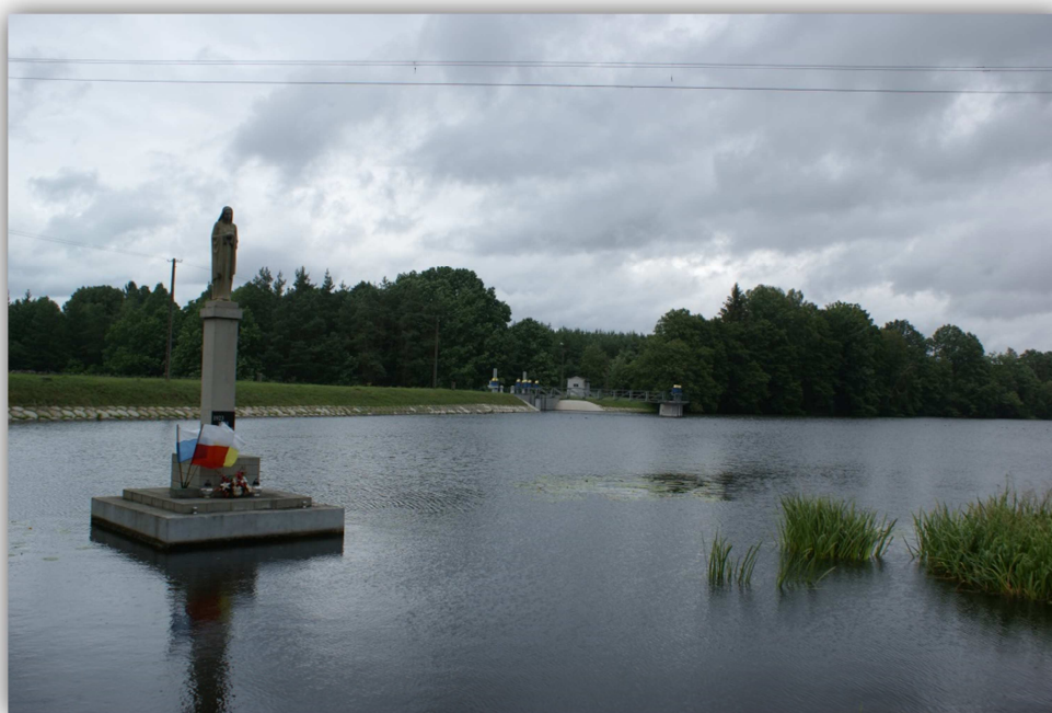
Zbiornik retencyjny „Gródek” przy elektrowni wodnej.
