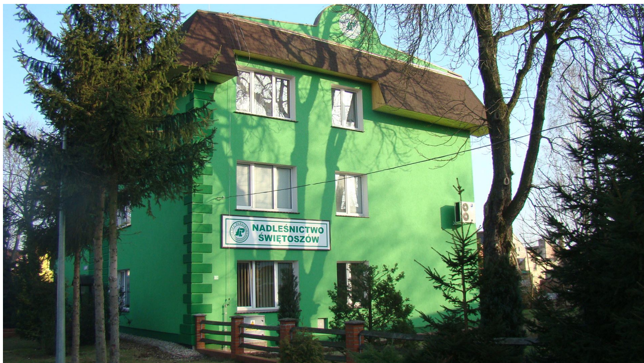
FOT. 1. SIEDZIBA NADLEŚNICTWA ZNAJDUJE SIĘ W ŚWIĘTOSZOWIE PRZY ULICY BRZOSZEJ 17 /FOT. ARCHIW.NADL/
