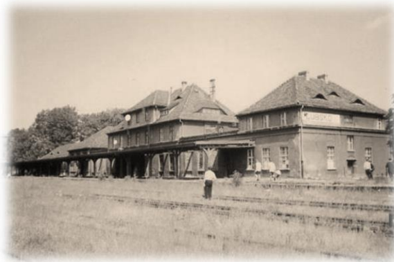
Fot. 63. Dawny budynek dworca wraz z wiatą peronową w Lubsku ( www.bazakolejowa.pl )
