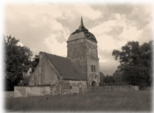
Fot. 45. Budynek wieży bramnej ( www.lwkz.pl )
