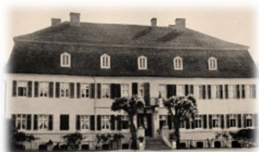
Fot. 55. Zabytkowy pałac w Jasionnej ( www.lwkz.pl )
