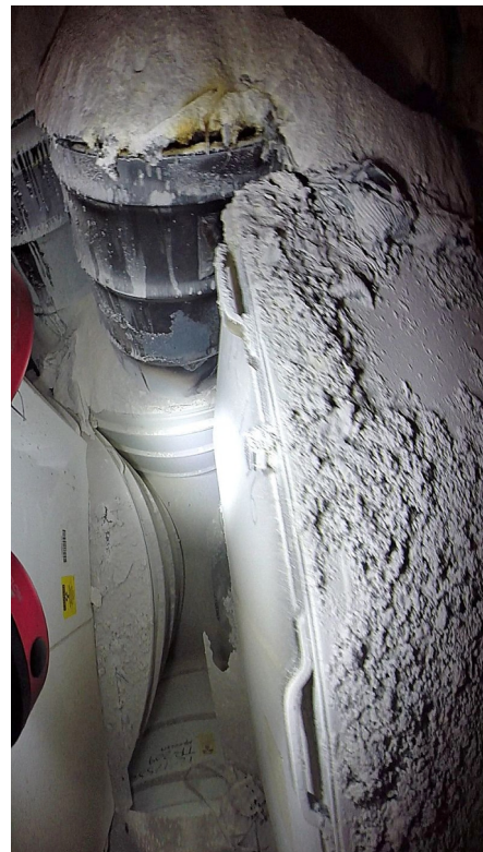
Fot. 6. Uszkodzona beczka LANL68660.
