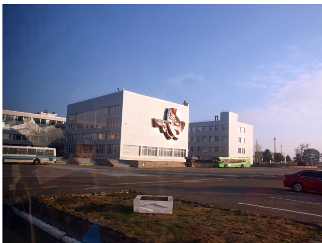
Rys. 3. Plac główny przed elektrownią.
