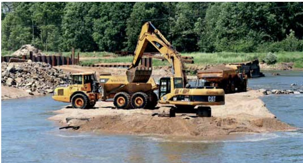
Lewin Brzeski. Prace w korycie rzeki. Fot. RZGW Wrocław
