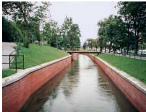
Kanal przebudowany w 2002 r. Fot. Lech Makara
