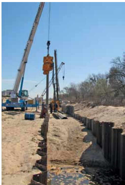
Budowa na plaży. Fot. UM Sopot
