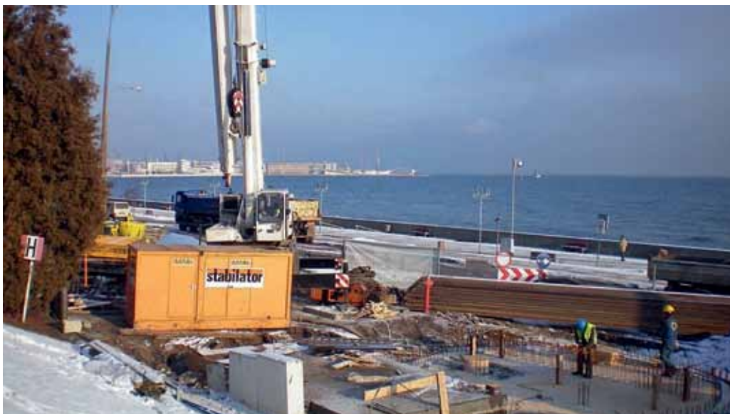
Budowa i przebudowa kanałów deszczowych w Alei Marszałka Piłsudskiego w Gdyni. Fot. J. Sokolnicki
