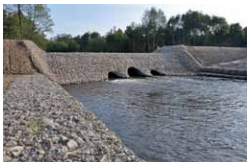
Zapora Osówko na Parsęcie. Fot. ZZMiUW Szczecin
