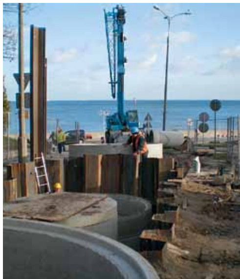
Prace inżynierskie tuż nad Zatoką Gdańską.
