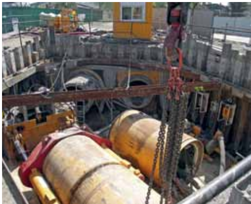
Odwodnienie terenu pod stadion, budowa kolektorów kanalizacji deszczowej
