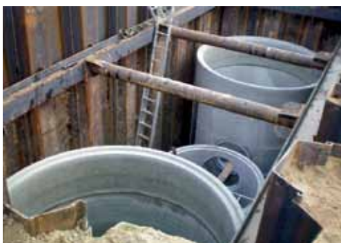
Budowa nowych kanałów deszczowych
