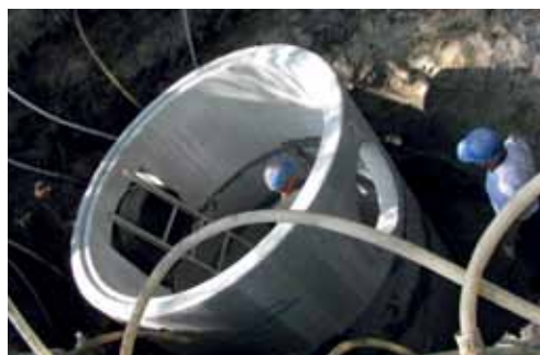
Montaż urządzeń podczyszczających. Fot. UM Sopot
