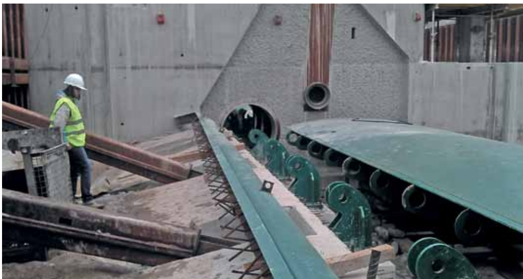
Budowa jazu klapowego na Nysie. Fot. RZGW Wrocław
