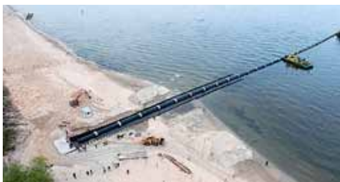
Budowa kanałów wylotowych. Fot. Aeromedia.pl
