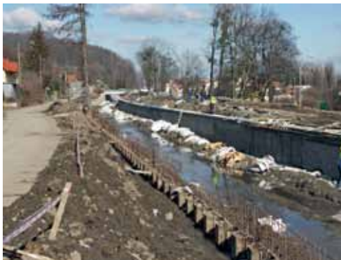
Przebudowa Kanału Raduni w marcu 2012. Fot. Lech Makara
