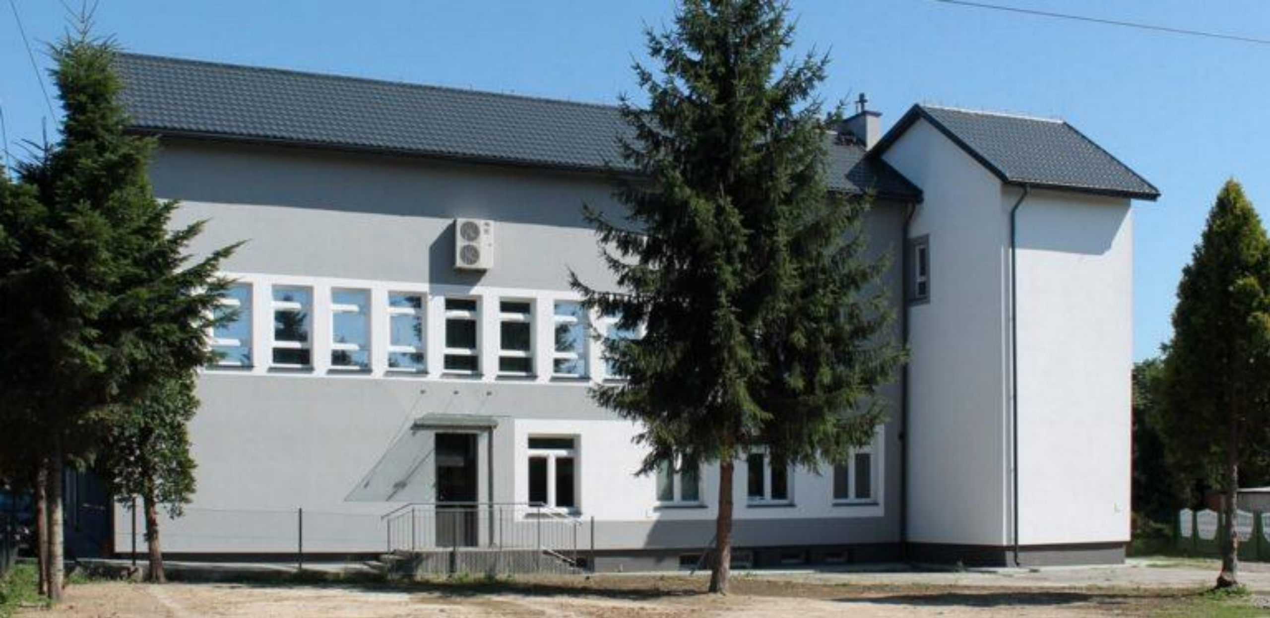
CENTRUM OPIEKUŃCZO-MIESZKALNE DLA OSÓB NIEPEŁNOSPRAWNYCH W WOLI MAŁEJ
