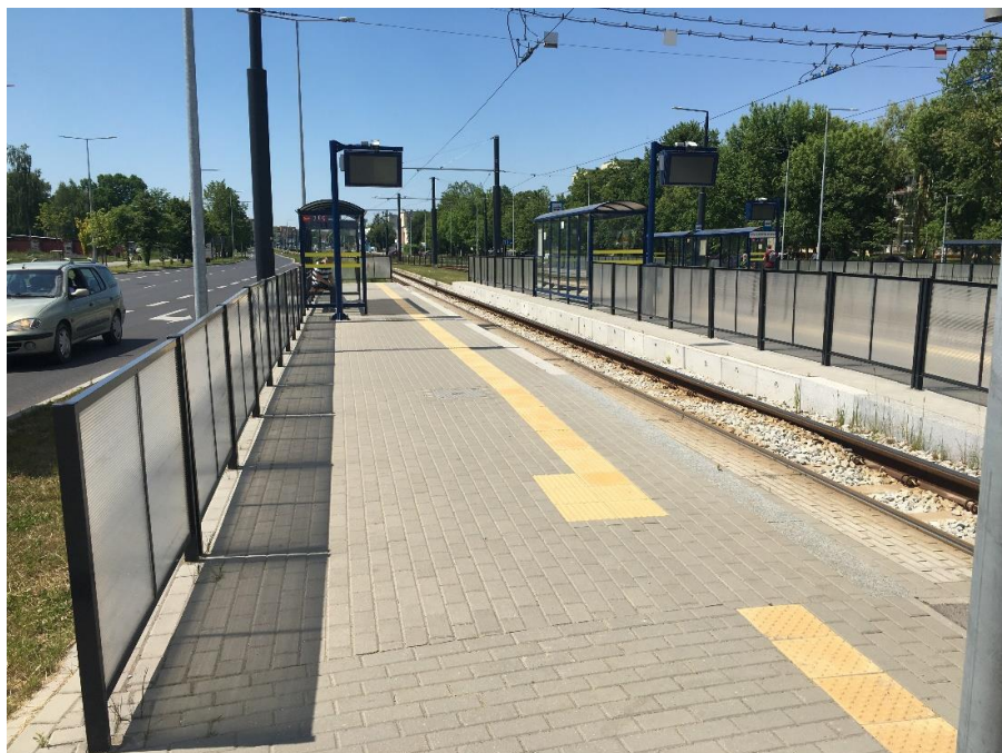
Rysunek 5. Peron przystanku tramwajowego - ścieżka prowadząca i pole wsiadania dla osób niewidomych i słabowidzących, oznaczona krawędź peronu kolorem kontrastowym (białym), system wizualnej informacji o przyjazdach i odjazdach z funkcją informacji głosowej, szklane ściany wiaty oznaczone pasami kontrastowymi
