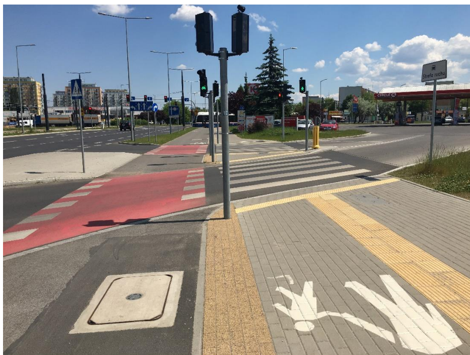
Rysunek 4. Droga dojścia do przystanków tramwaju miejskiego - brak krawężników, ścieżka prowadząca i pole ostrzegawcze dla niewidomych i słabowidzących
