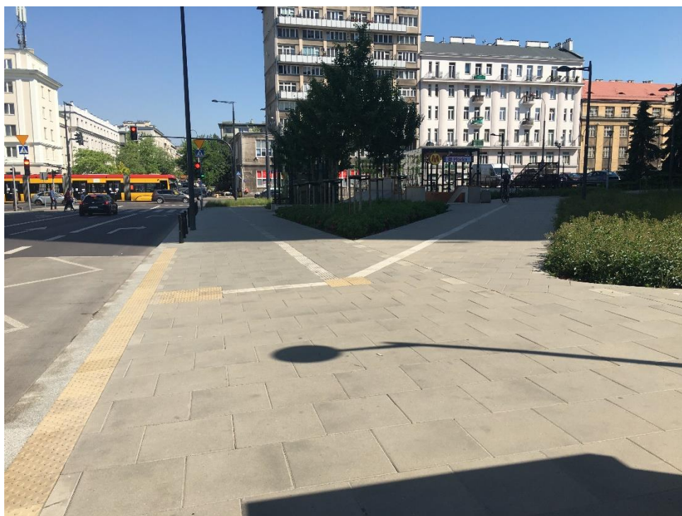
Rysunek 12. Zieleńce tworzące wizualne ciągi komunikacyjne prowadzące do wejścia do metra. Zieleńce stanowią również naturalne elementy prowadzące dla osób niewidomych w sytuacji, gdy osoba niewidoma nie odnajdzie ścieżki prowadzenia
