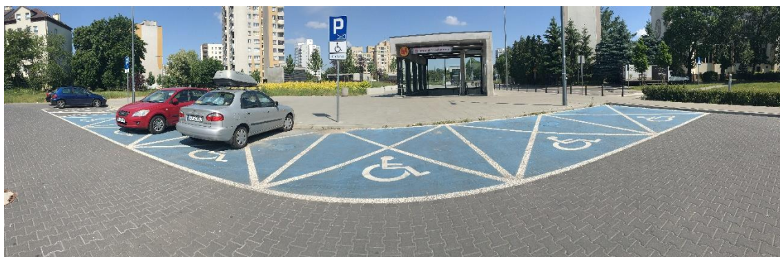
Rysunek 23. Miejsca parkingowe przy stacji metra - brak obniżenia krawężników uniemożliwia osobom na wózku wjechanie na chodnik i dotarcie do wejście na stację metra
