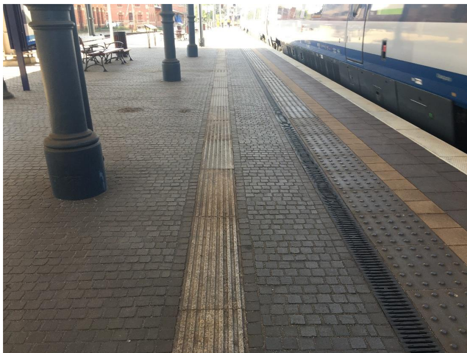
Rysunek 3. Oznaczenie krawędzi peronu na dworcu kolejowym kolorem i fakturą - pas ostrzegawczy i ścieżka prowadząca
