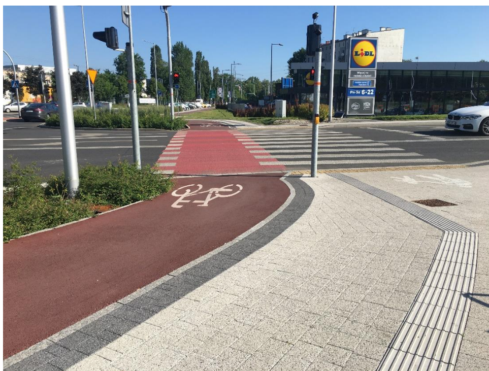
Rysunek 14. Kolorystyczne rozróżnienie ciągu pieszego i ścieżki rowerowej oraz ścieżka dla osób niewidomych na drodze dojścia do dworca przesiadkowego
