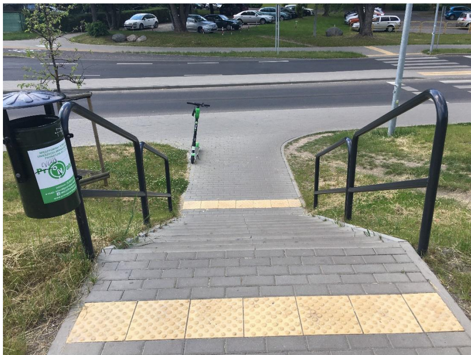
Rysunek 7. Droga dojścia na przystanek tramwaju - pasy ostrzegawcze przed schodami, poręcz po obu stronach
