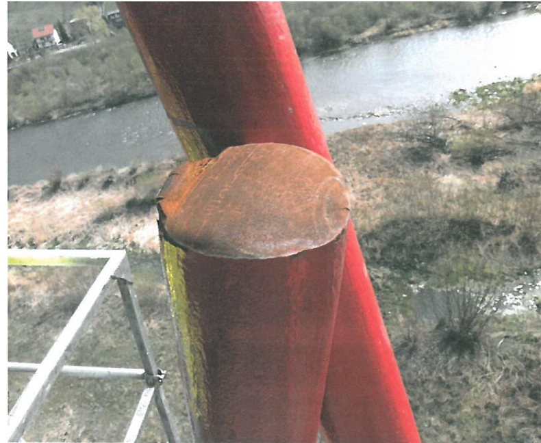
Fot.2 Pęknięty wieszak W13 odchylony od swojego położenia osiowego
