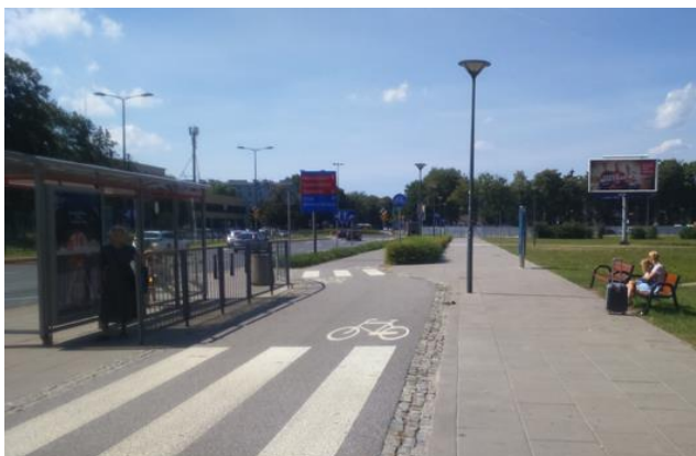
Fot. 6.23. Infrastruktura w rejonie przystanków komunikacji publicznej – droga dla rowerów omija zatokę autobusową z tyłu
