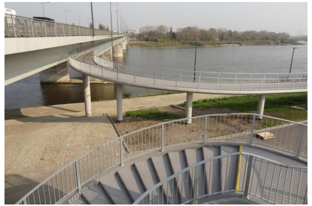
Fot. 6.39 Droga dla rowerów na moście
