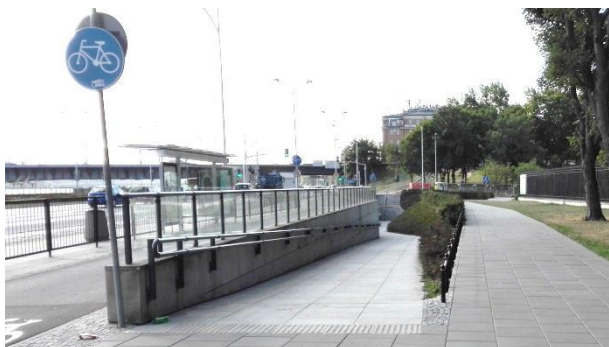
Fot. 6.42 Przepust dla pieszych i rowerzystów
