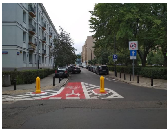
Fot. 6.11. Dwukierunkowy ruch rowerów na drodze jednokierunkowej, bez wyznaczonych na jezdni pasów (kontraruch) – wyjazd
