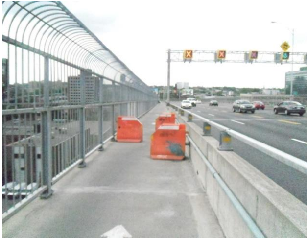
Fot. 6.29. „Szykany” na drodze dla rowerów na moście wymuszające ograniczenie prędkości
