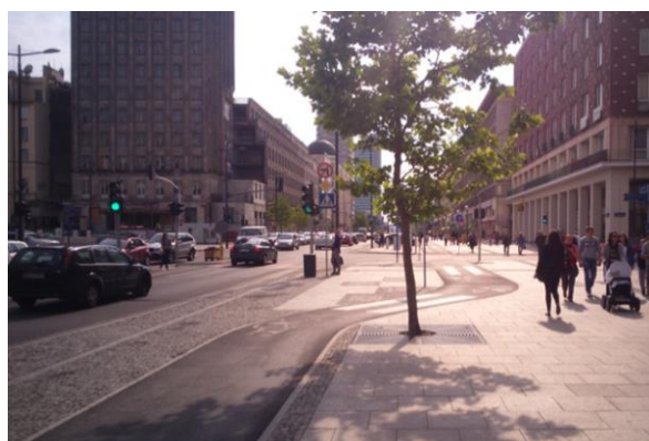
Fot. 6.13. Odgięcie dwukierunkowej drogi dla rowerów w obrębie skrzyżowania
