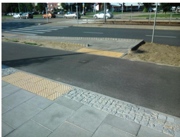
Fot. 6.34 Infrastruktura dla niepełnosprawnych – zjazd dla wózków inwalidzkich
