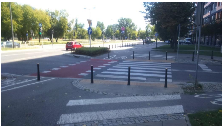
Fot. 6.37 Poszerzony wlot na dwukierunkową drogę dla rowerów ze słupkami blokującymi
