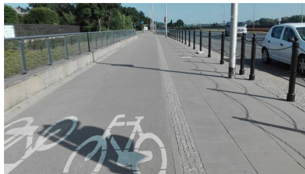
Fot. 6.4. Droga dla rowerów oddzielona od chodnika przebrukowaniem
