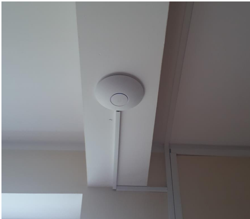
Fot. 1: Zdjęcie punktu dostępowego model UAP-AC-LR
