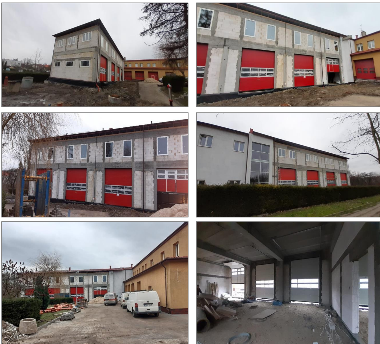
Fot. 32 Rozbudowa JRG 2 w Słupsku.
