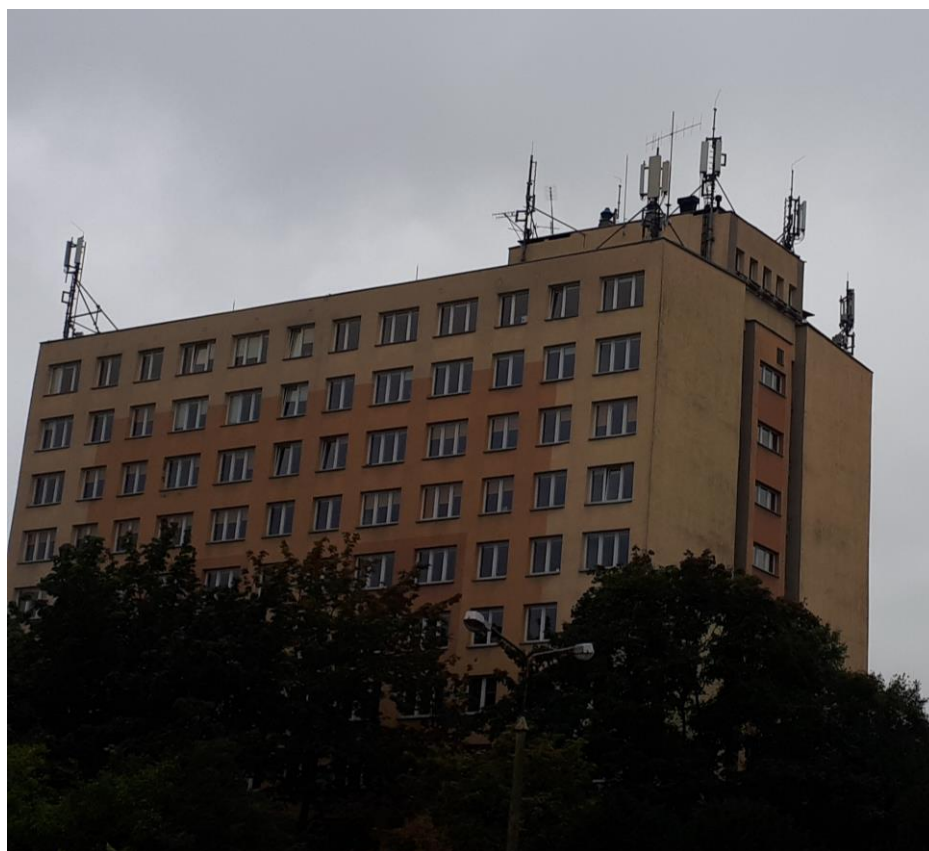
Fot. 1: Widok anten stacji bazowych: ID: 53109 (37109N!), ID: BT 22659, zlokalizowanych pod adresem: ul. Grunwaldzka 31, 45-054 Opole
