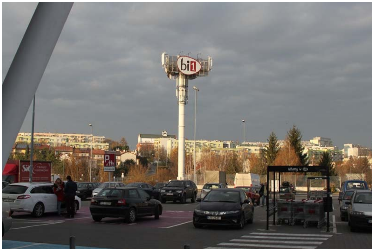
Fot. 1: Widok wieży stacji bazowych: ID stacji: RZE1020_H, ID stacji: BT24858, ID stacji: 58385 zlokalizowanej na terenie centrum handlowego w Rzeszowie przy Al. Wincentego Witosa 21 (widok z punktu pomiarowego nr 12)
