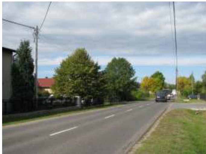
Fot. 2. Poczesna, RB1, ul. Gliwicka (DW 791) w kierunku centrum Poczesnej
