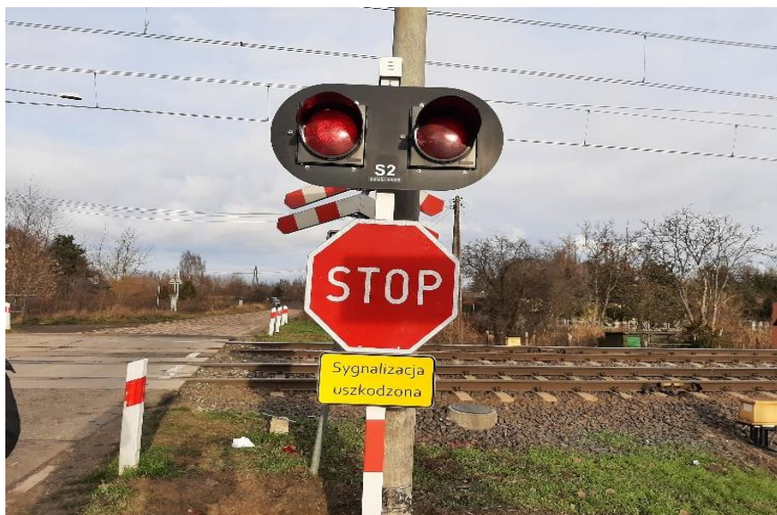
Zdjęcie 4 – Oznakowanie przejazdu po przyjeździe przedstawicieli PKBWK
