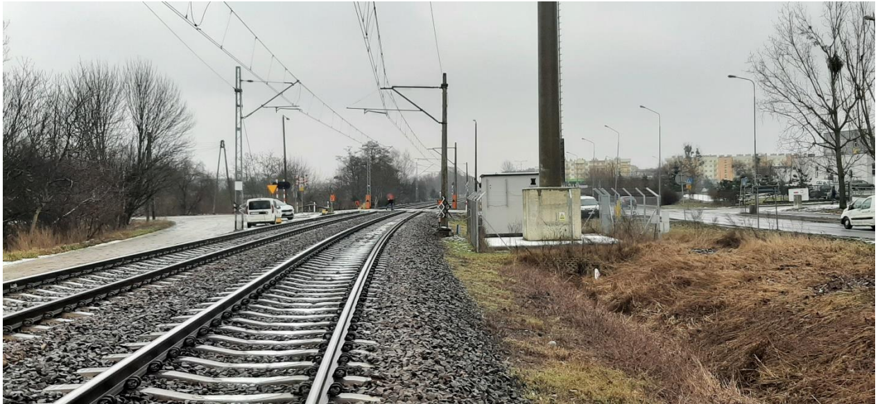
Zdjęcie 7 – Widok z toru nr 2 na drogę dojazdową i przejazd w km.11,788 z odległości ok. 80 metrów
