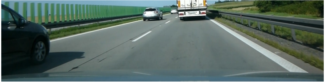
Stan nawierzchni A4-km 137
