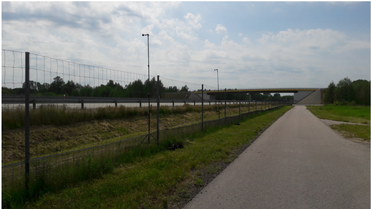
Rys. 11.8. Lokalizacja mierników w punkcie pomiarowym na drodze ekspresowej S8 Węzeł Rzgów - Róża
