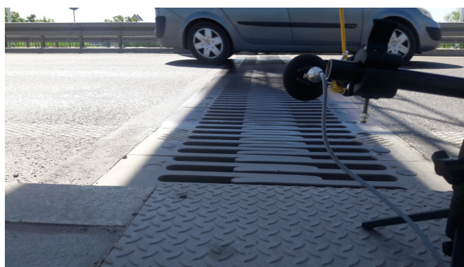
Rys. 12.17 Widok na punkt pomiarowy PPH-3 przy dylatacji palczastej
