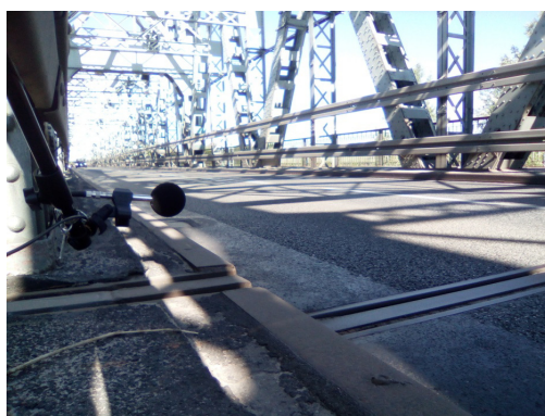
Rys. 12.21 Widok na punkt pomiarowy PPH-6 przy dylatacji dwumodułowej
