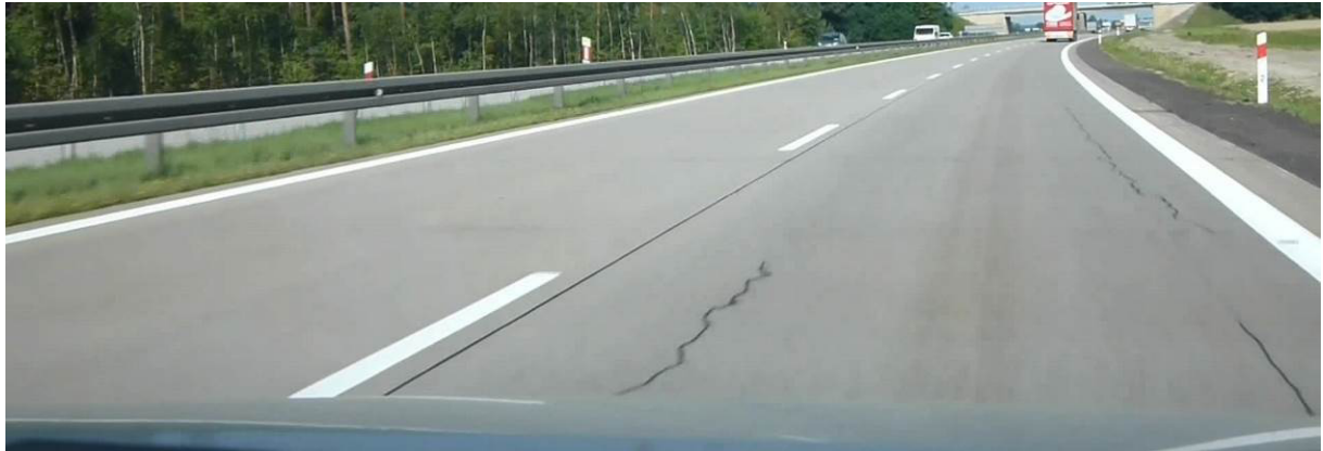
Stan nawierzchni A4-km 53
