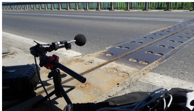
Rys. 12.23 Widok na punkt pomiarowy PPH-7 przy dylatacji blokowej
