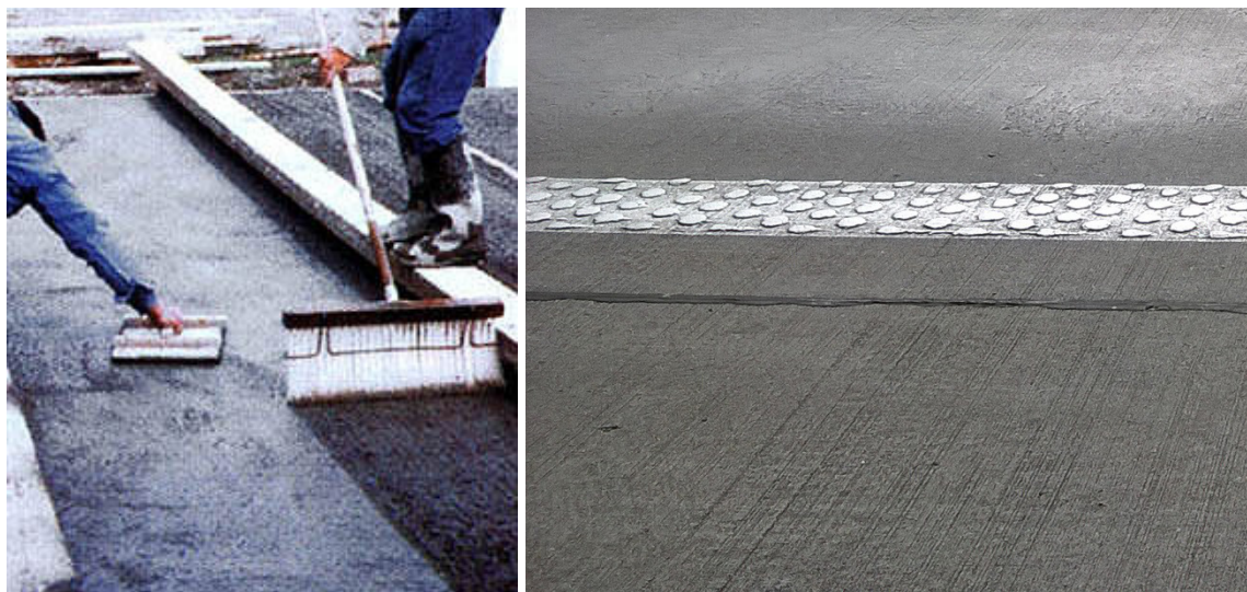
Rys. 2.15. Teksturowanie górnej powierzchni w kierunku poprzecznym [111]
