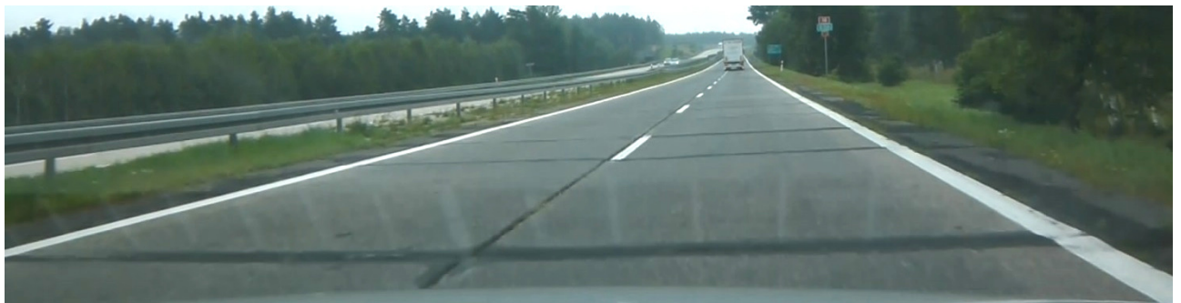
Stan nawierzchni A18-km 54
