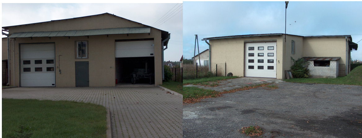
Odnowione budynki gospodarcze komendy
