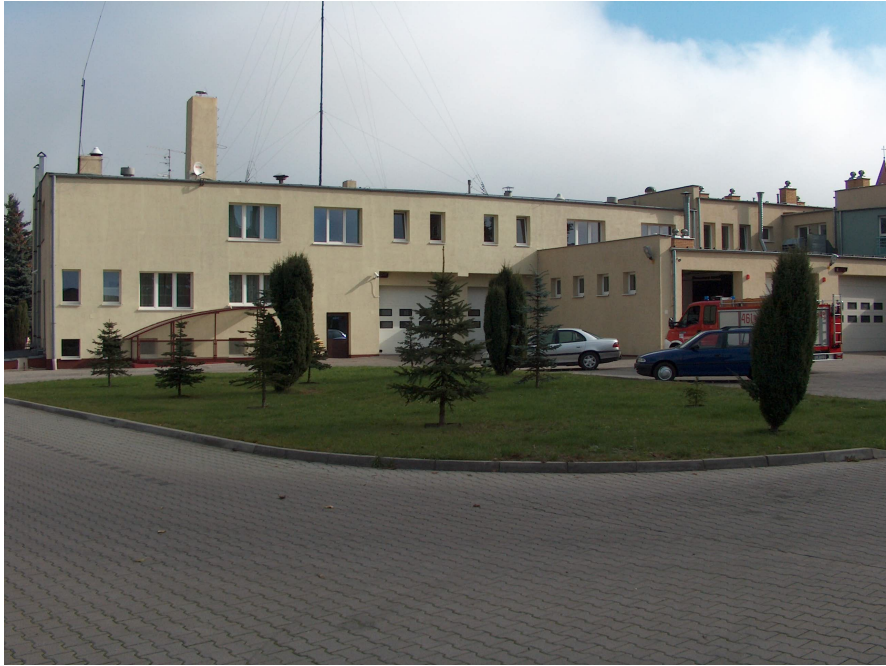
Skwerek zieleni wybudowany w miejscu byłej stacji paliw
