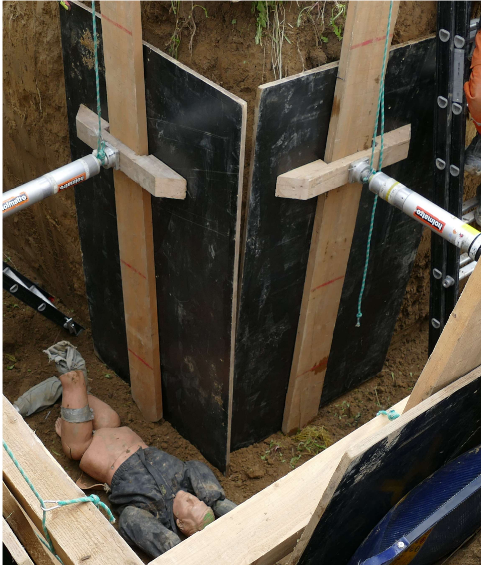
Fot. 50. Zabezpieczenie rozporami narożnika wewnętrznego
