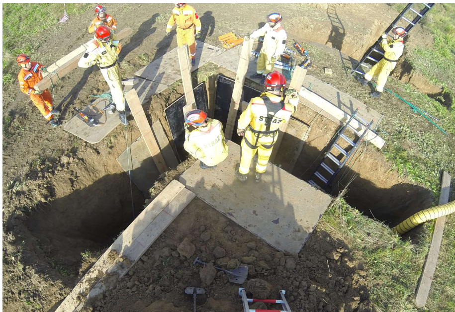
Fot. 46. Montaż paneli na ścianach przy narożniku zewnętrznym
