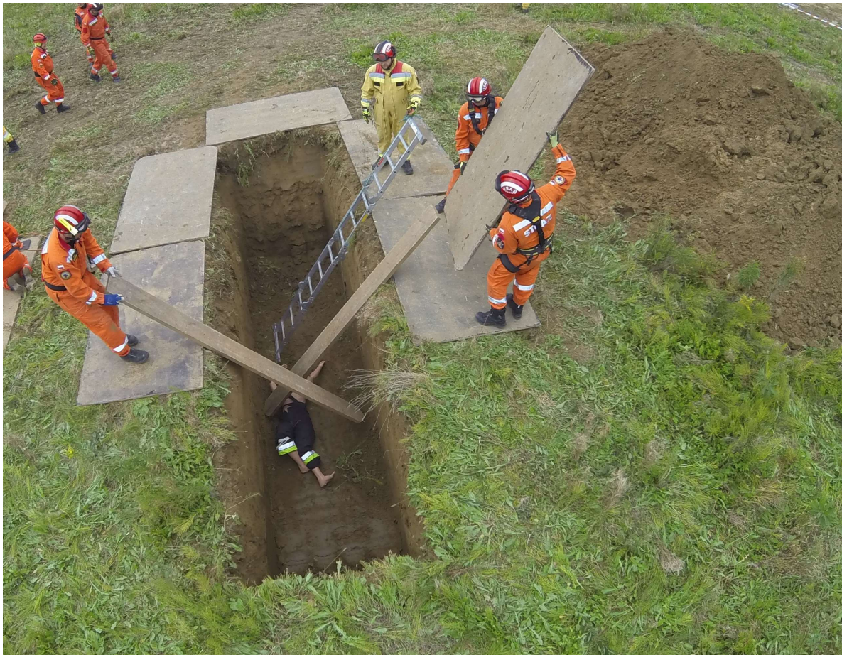
Fot. 26. Sposób montażu panelu zabezpieczającego w wykopie – 1
