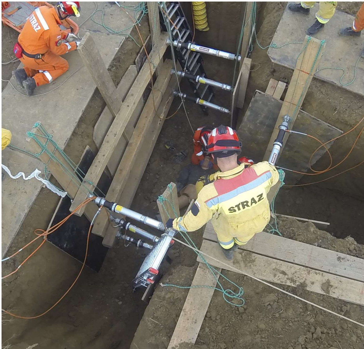
Fot. 43. Gotowe zabezpieczenie wykopu typu „T”
