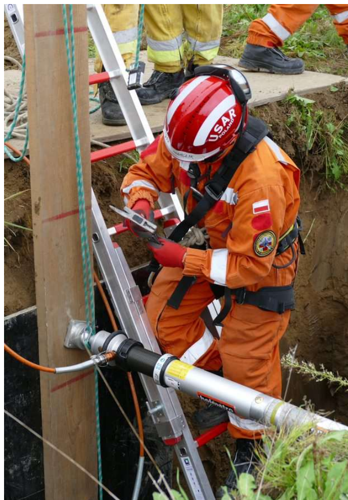
Fot. 31. Bezpieczna głębokość wejścia do wykopu
