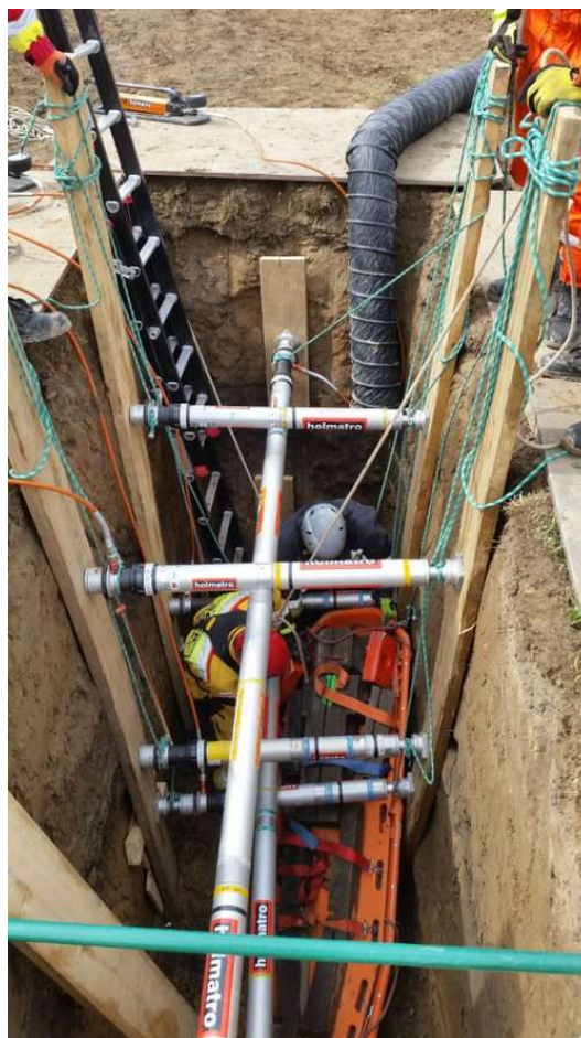
Fot. 25. Zabezpieczenie brzegów wykopu przy pomocy desek
