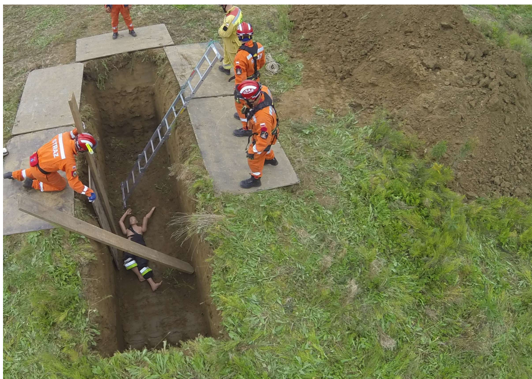
Fot. 28. Sposób montażu panelu zabezpieczającego w wykopie – 3
