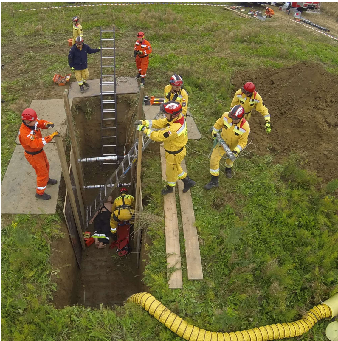
Fot. 34. Montaż pozostałych par paneli
