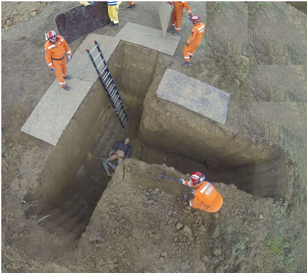
Fot. 2. Wykop typu „T”
