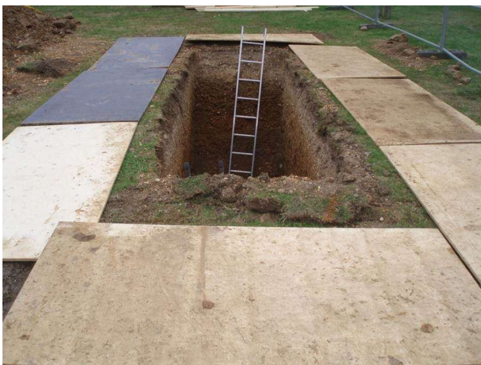
Fot. 20. Umocnienie brzegów wykopu przy pomocy płyt szalunkowych
