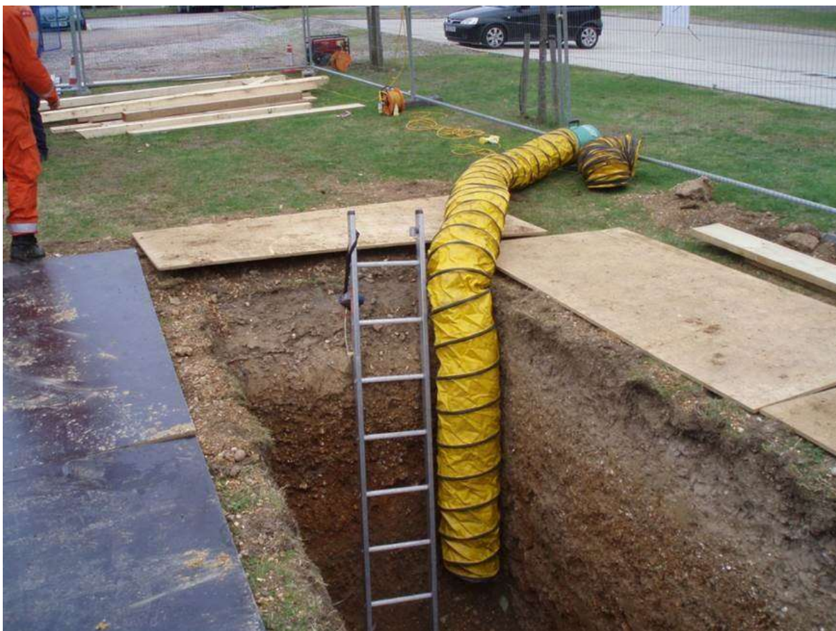
Fot. 23. Wentylacja wykopu
