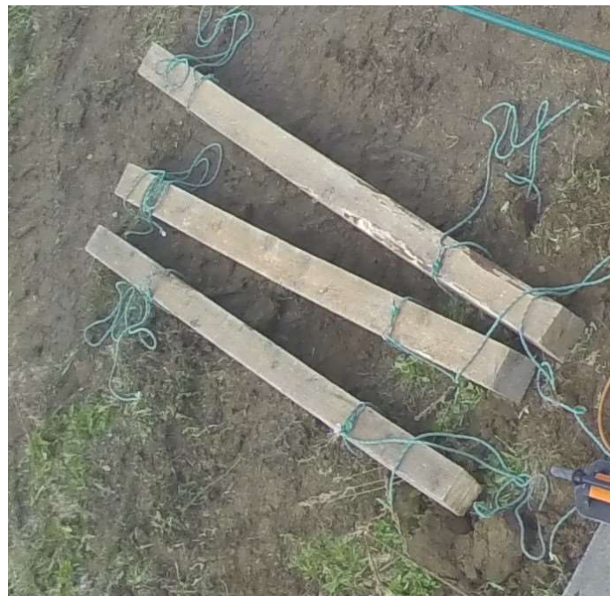
Fot. 16. Belki wzmacniające przygotowane do opuszczenia do wykopu
