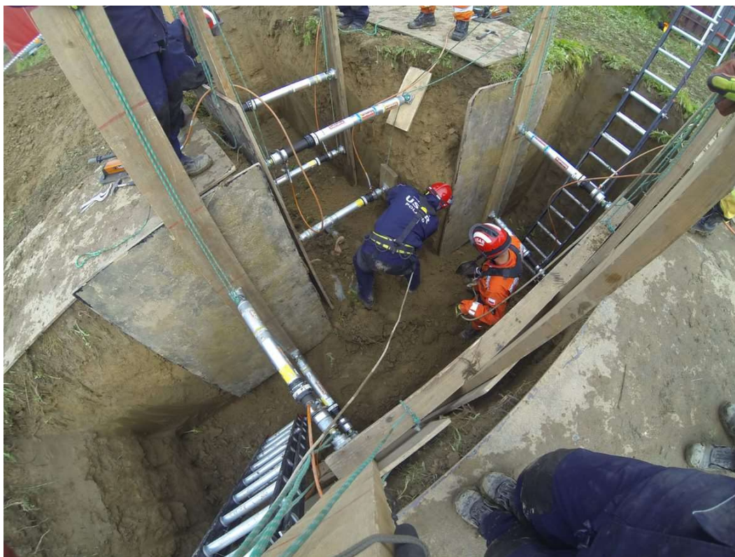
Fot. 41. Narożniki zabezpieczone deskami
