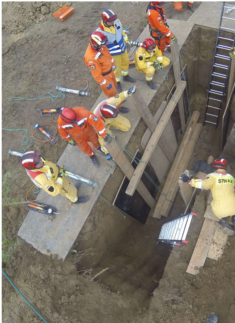
Fot. 39. Wykorzystanie belek wzmacniających
