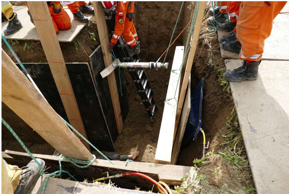
Fot. 48. Zabezpieczenie narożnika wewnętrznego przy pomocy paneli
