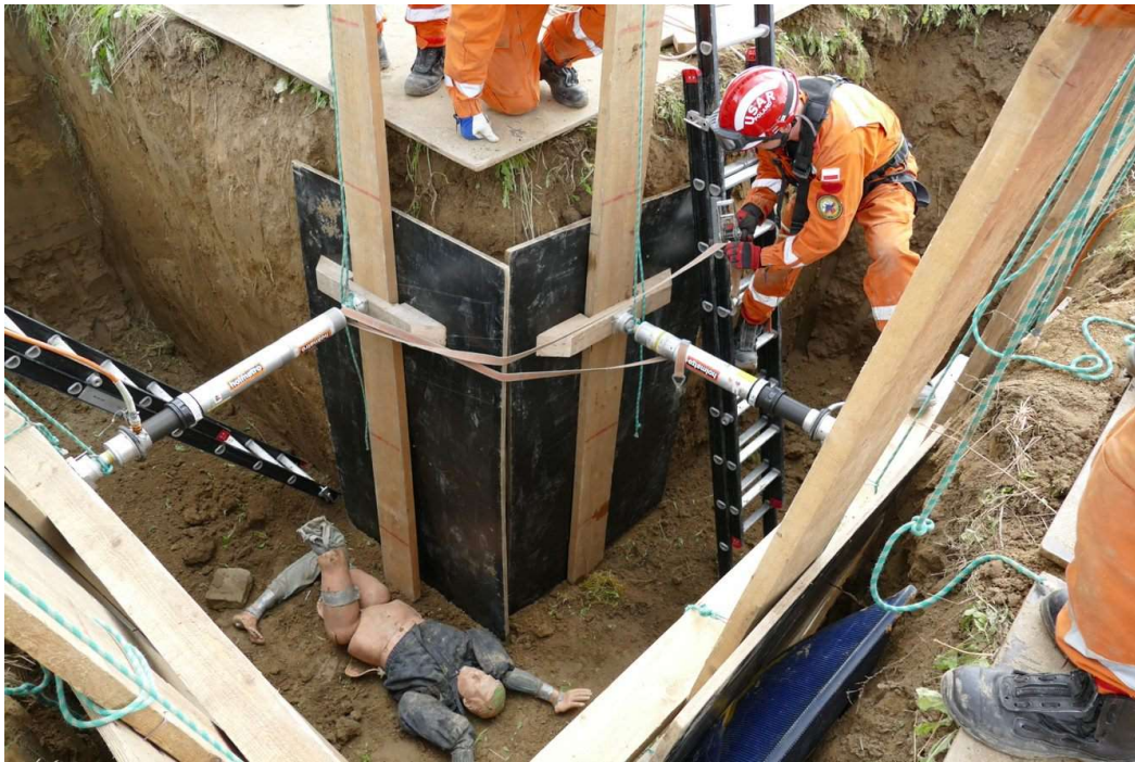
Fot. 51. Połączenie rozpór pasem napinającym
