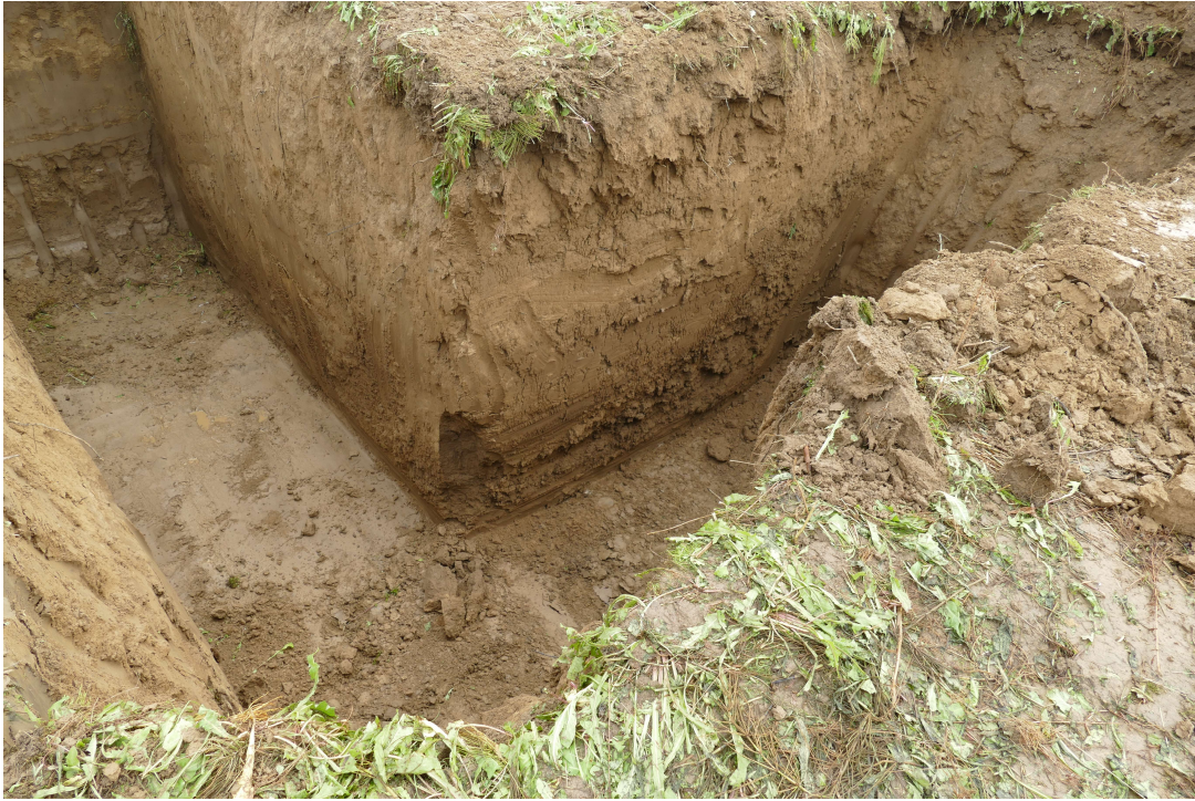
Fot. 3. Wykop typu „L”
