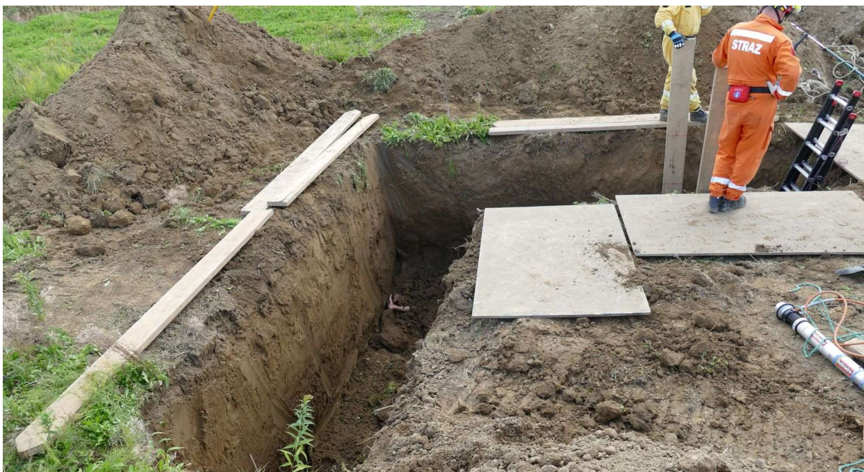
Fot. 21. Umocnienie brzegów wykopu przy pomocy desek
