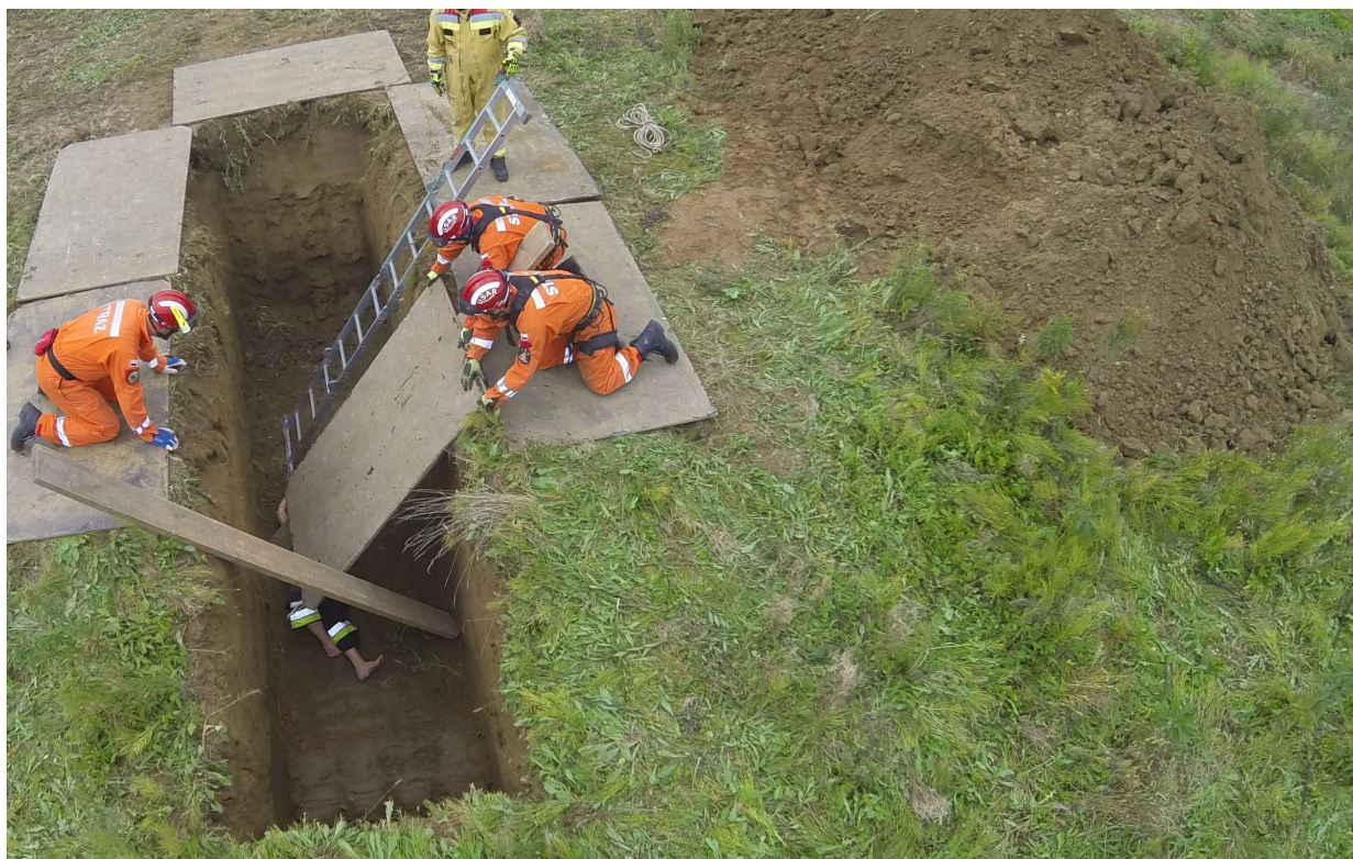
Fot. 27. Sposób montażu panelu zabezpieczającego w wykopie – 2
