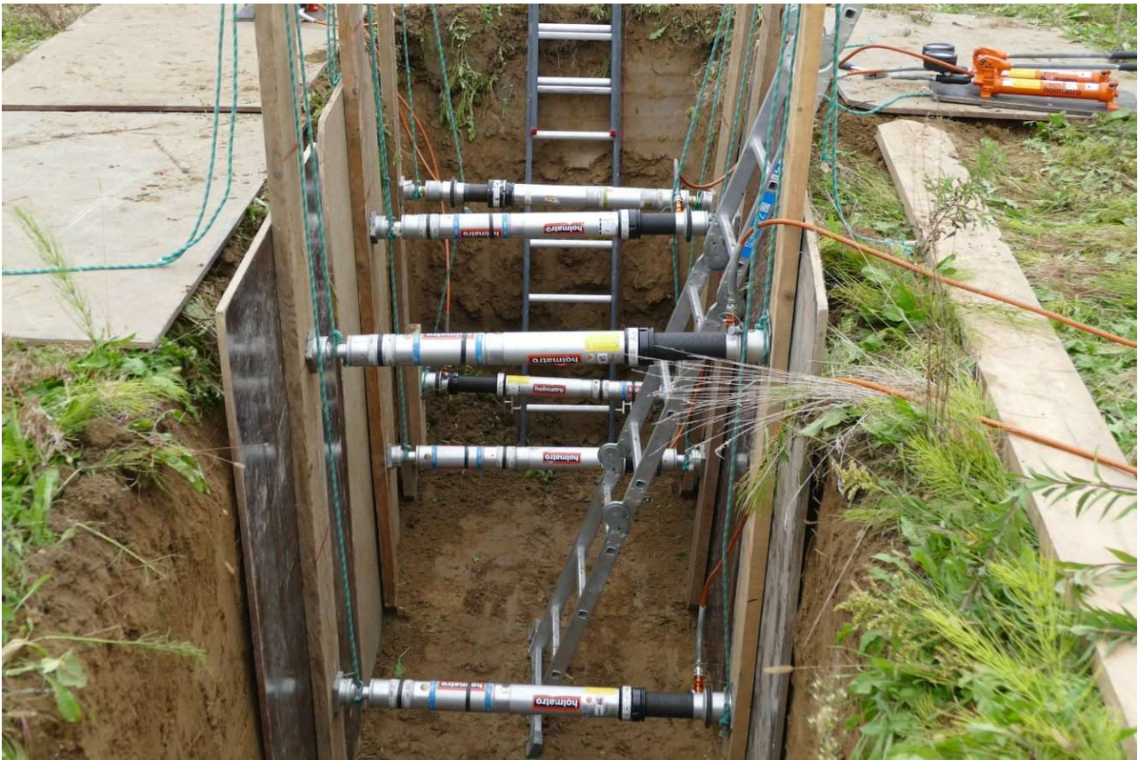
Fot.24. Zabezpieczenie brzegów wykopu przy pomocy paneli
