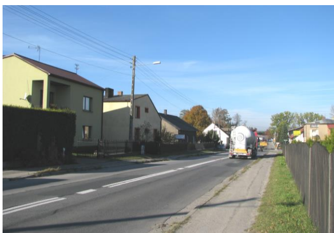
Fot. 5. Zawady, RB2. Badany odcinek ul. Częstochowskiej (DW 491) w kierunku Wielunia
