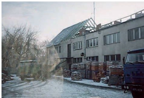
Rozbudowa strażnicy zima 2002/2003 r.
