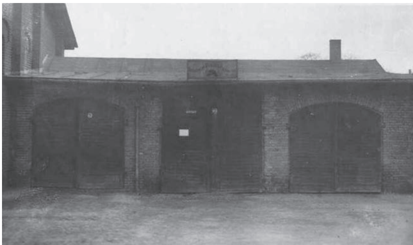
Pomieszczenia garażowe OSP oraz KSP w Pleszewie przy Placu Kościuszki.
