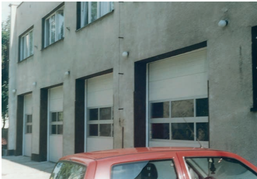
Budynek po wymianie okien i bram drewnianych na panelowe, sterowane przez dyspozytora. 2001 r.
