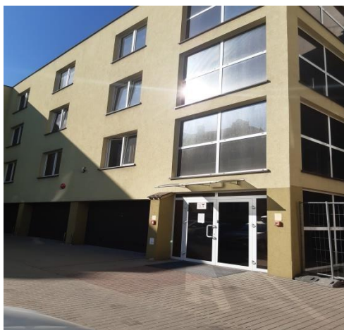
Rys. nr 2 Wejście główne do Archiwum Zakładowego KOWR OT OPOLE od strony bramy wjazdowej na ul. 1 Maja
