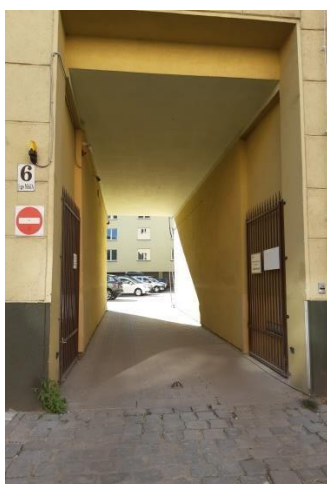
Rys. nr 3 Brama wjazdowa na parking wewnętrzny KOWR OT OPOLE od strony ul. 1 Maja 6
