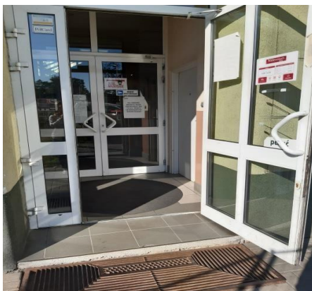
Rys. nr 6 Wejście główne do siedziby KOWR OT OPOLE od ul. Reymonta z progiem - drzwi podwójne.
