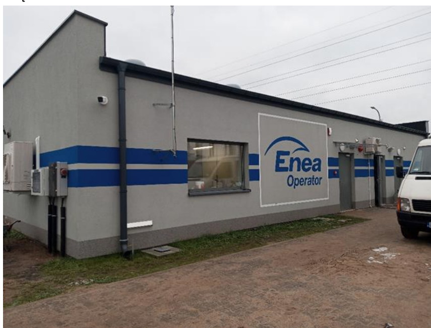
1. Rozdzielnia sieciowa w obrębie Mierzęcina, gmina Dobiegniew.
