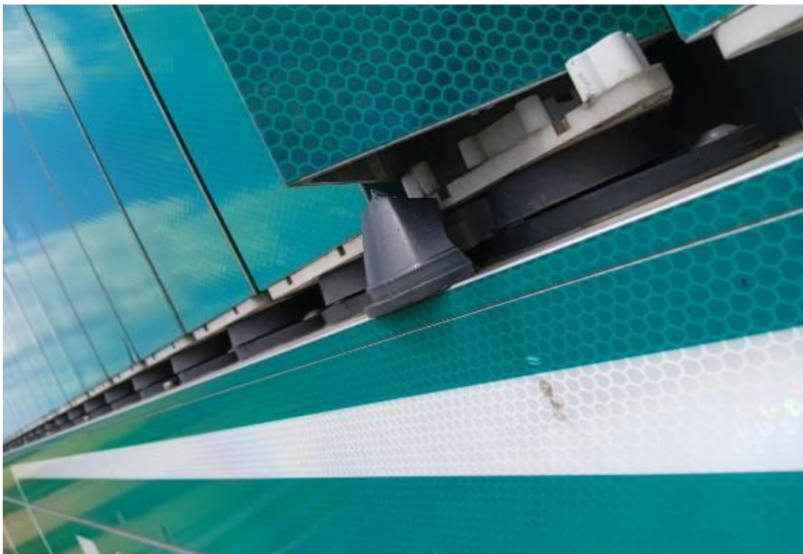
Zdjęcie 4. Mocowanie dolne pryzmatu. Pryzmat poza podstawą montażową. Widoczny fragment uszkodzonego mocowania górnego.
