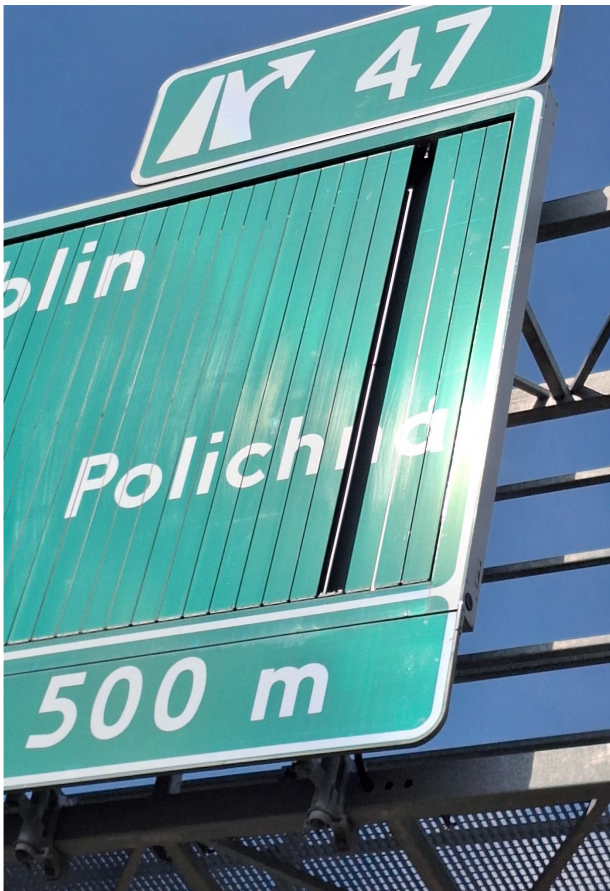
Zdjęcie 5. Widok po demontażu pryzmatu znaku.
