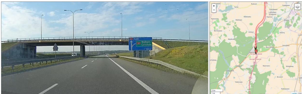
Rys. 3.9 Autostrada A1 – przykład wiaduktu z rezerwą terenu na poszerzenie drogi po zewnętrznej stronie.
