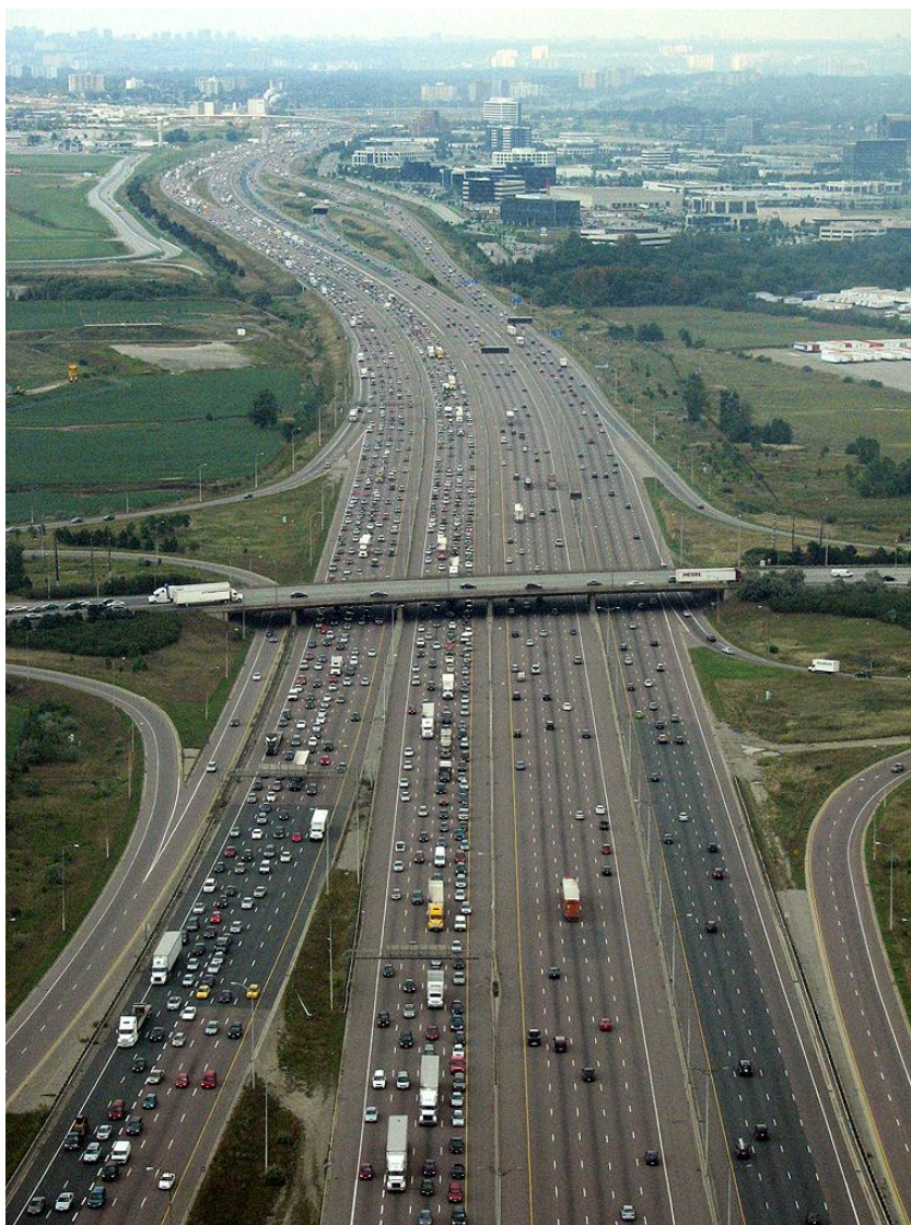
Rys. 2.34 Widok przekroju miejskiej, czterojezdniowej, wielopasowej autostrady – Highway 401 in Southern Ontario w Toronto, Kanada.
