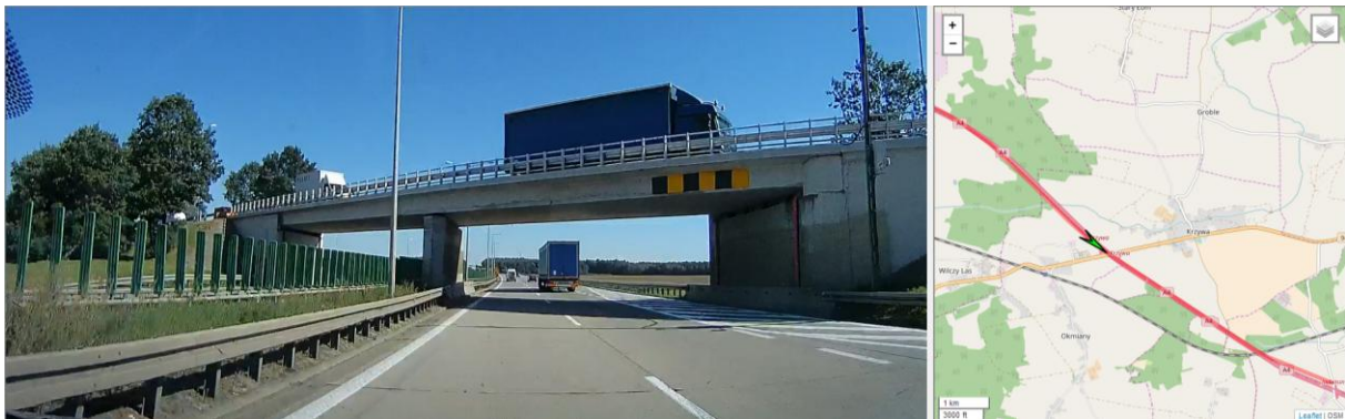
Rys. 3.12 Autostrada A4 – przykład wiaduktu bez rezerwy terenu na poszerzenie drogi.
