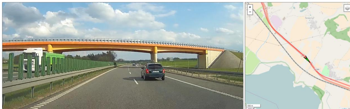
Rys. 3.14 Droga ekspresowa S7 – przykład wiaduktu bez rezerwy terenu na poszerzenie drogi.
