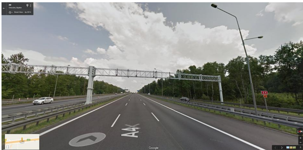
Rys. 3.6 Autostrada A4 – odcinek węzeł Ruda Śląska – węzeł Katowice – przykład przekroju autostrady z dodatkowymi jezdniami (2/3+2s).
