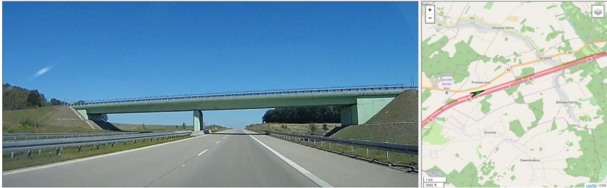
Rys. 3.11 Autostrada A4 – przykład wiaduktu z rezerwą terenu na poszerzenie drogi po zewnętrznej stronie.
