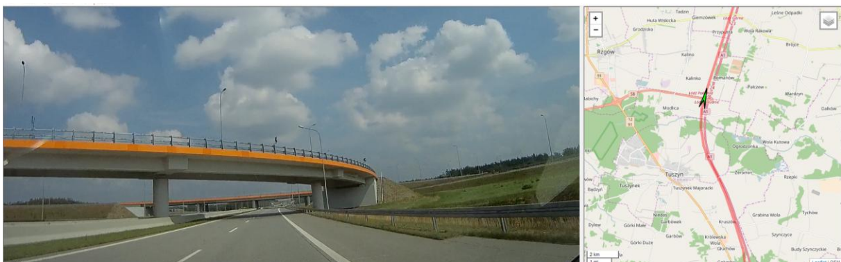
Rys. 3.10 Autostrada A1 – przykład wiaduktu bez rezerwy terenu na poszerzenie drogi.
