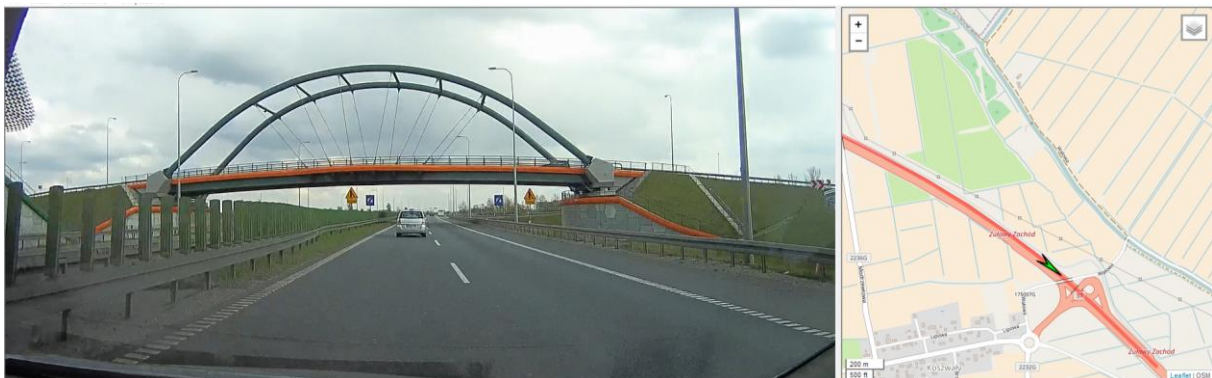
Rys. 3.13 Droga ekspresowa S7 – przykład wiaduktu z rezerwą terenu na poszerzenie drogi po zewnętrznej stronie.
