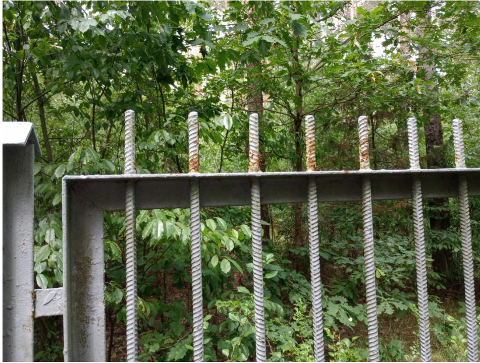
Fot. 29 – Ogrodzenie wieży
