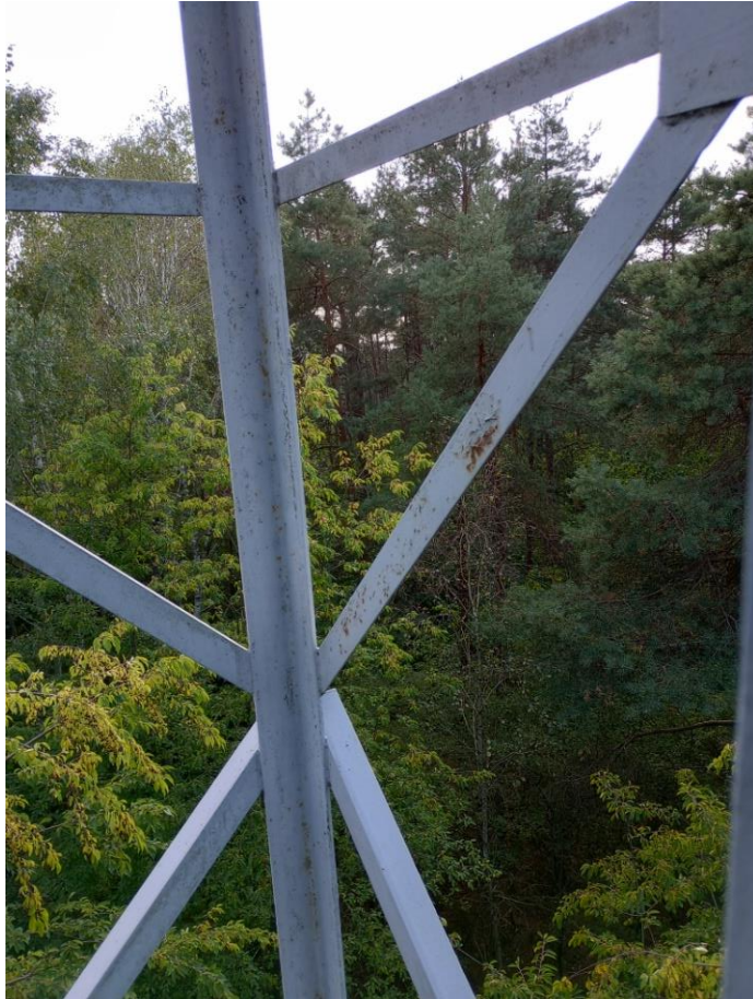
Fot. 13 – Wieża przeciwpożarowa – konstrukcja
