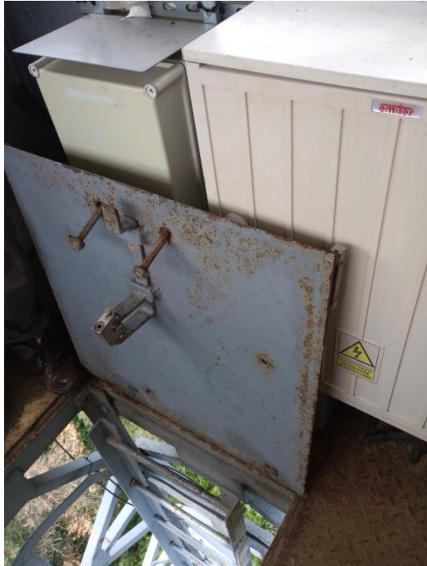
Fot. 19 – Kabina obserwacyjna – podłoga
