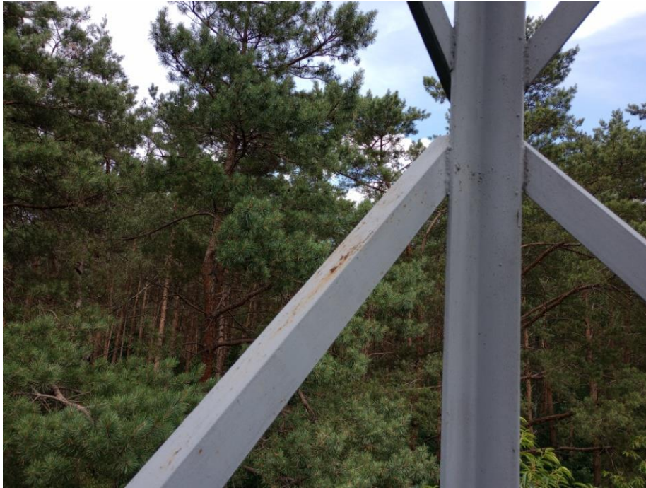
Fot. 11 – Wieża przeciwpożarowa – konstrukcja
