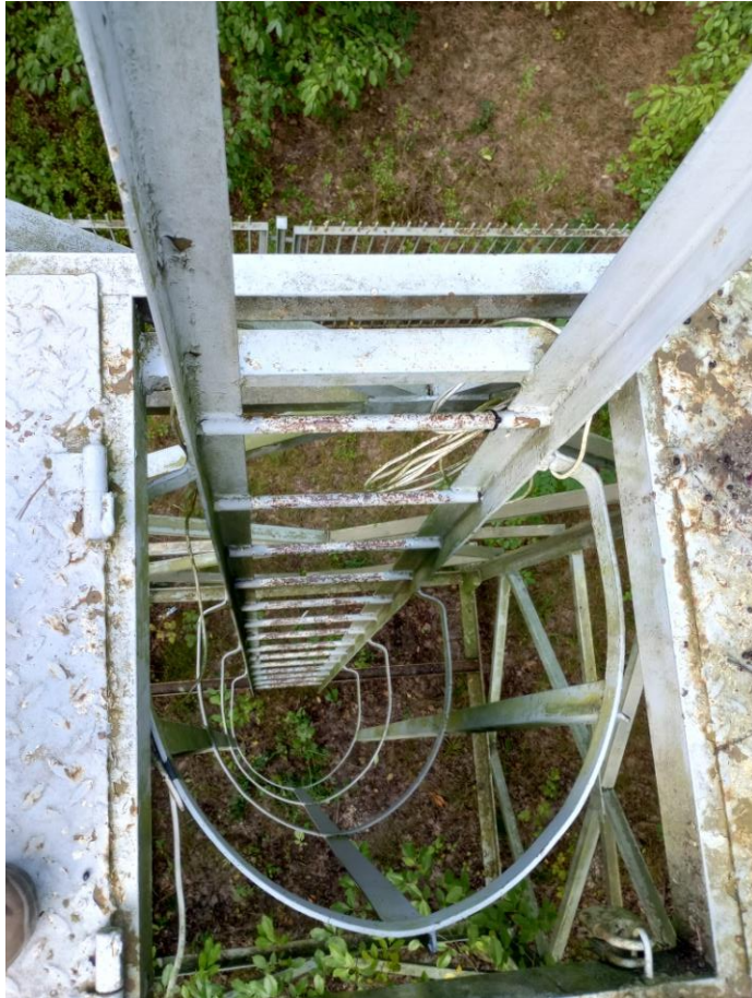
Fot. 17 – Wieża przeciwpożarowa – konstrukcja
