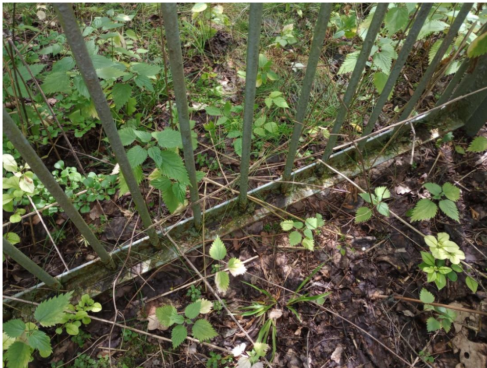
Fot. 30 – Ogrodzenie wieży
