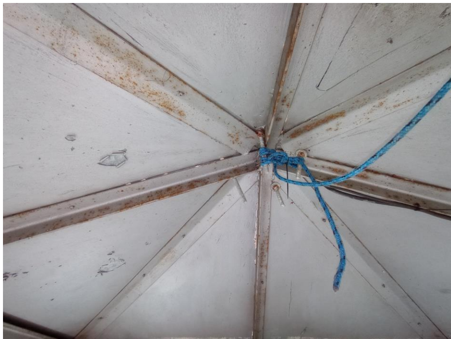
Fot. 4 – Kabina obserwacyjna – dach
