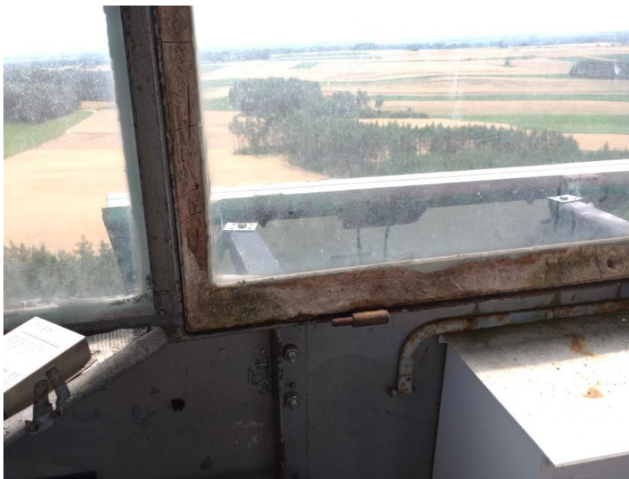
Fot. 5 – Kabina obserwacyjna – okno
