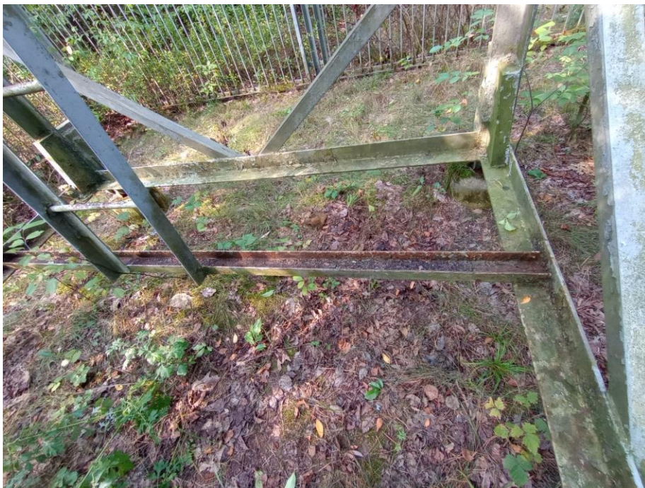
Fot. 18 – Wieża przeciwpożarowa - konstrukcja
