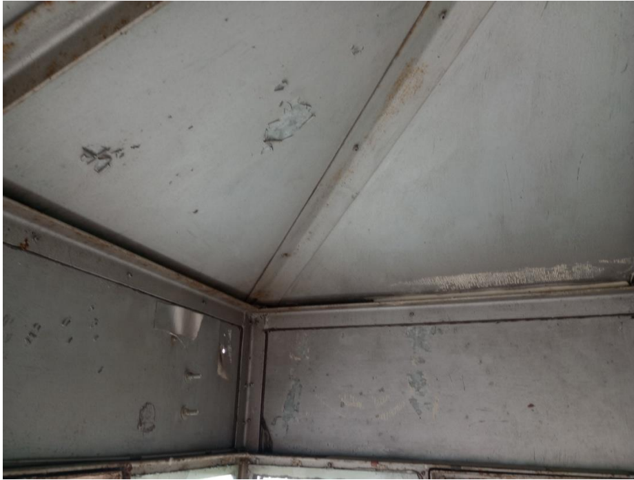
Fot. 3 – Kabina obserwacyjna – ściana i dach
