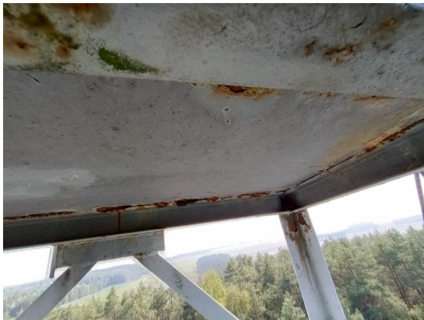
Fot. 26 – Podest wieży na poziomie 23,38 m
