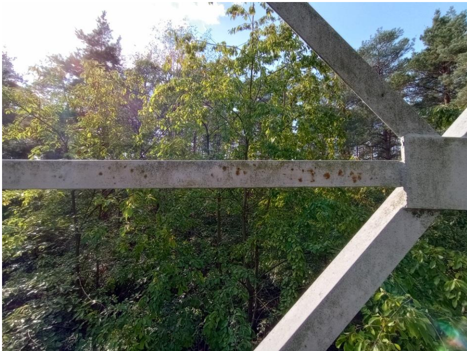
Fot. 14 – Wieża przeciwpożarowa – konstrukcja
