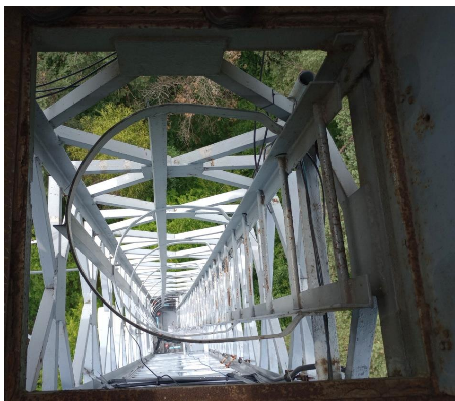
Fot. 6 – Wieża przeciwpożarowa – konstrukcja
