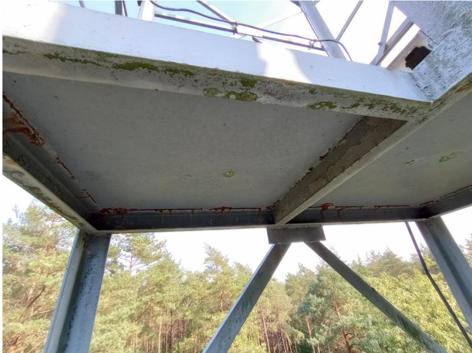
Fot. 9 – Podest wieży na poziomie 14,35 m
