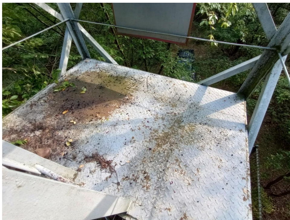
Fot. 16 – Podest wieży na poziomie 5,05 m
