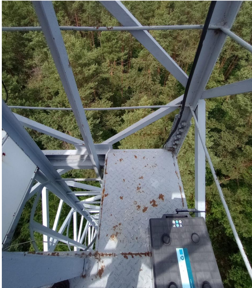
Fot. 24 – Podest wieży na poziomie 23,38 m
