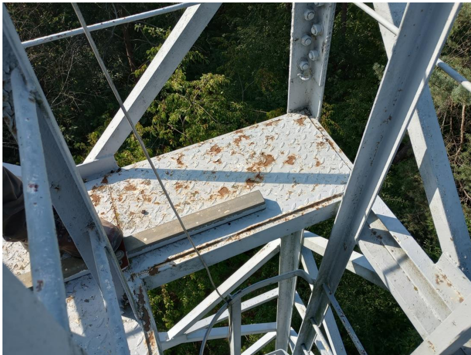
Fot. 8 – Podest wieży na poziomie 14,35 m
