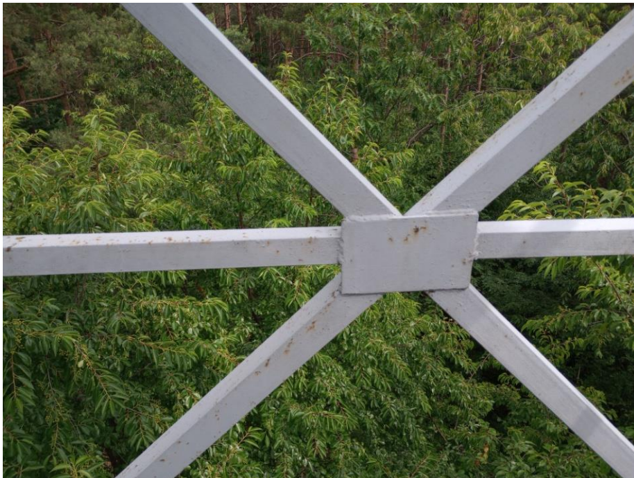
Fot. 12 – Wieża przeciwpożarowa – konstrukcja
