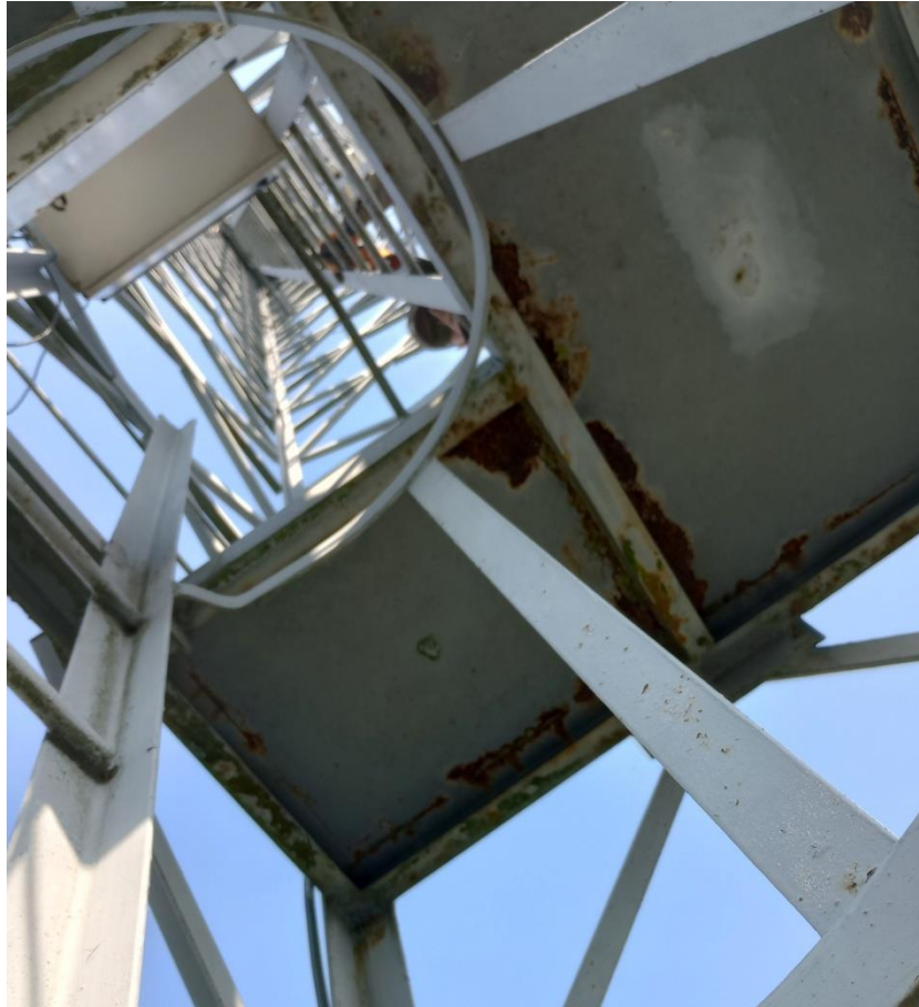
Fot. 25 – Podest wieży na poziomie 23,38 m
