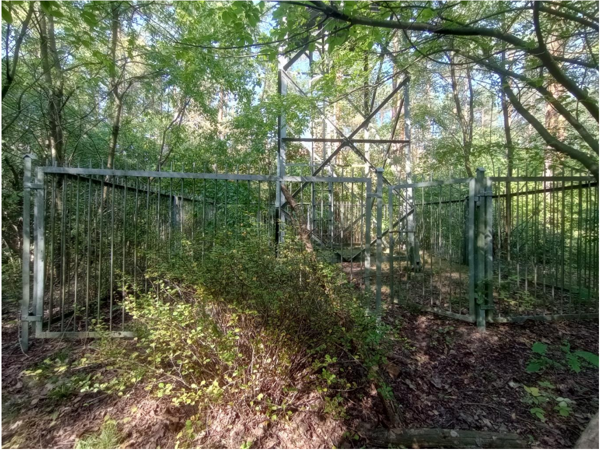
Fot. 27 – Ogrodzenie wieży
