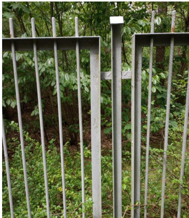
Fot. 28 – Ogrodzenie wieży
