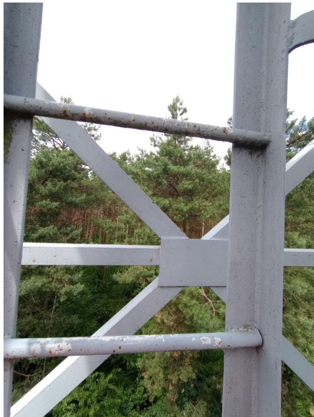
Fot. 10 – Wieża przeciwpożarowa – konstrukcja
