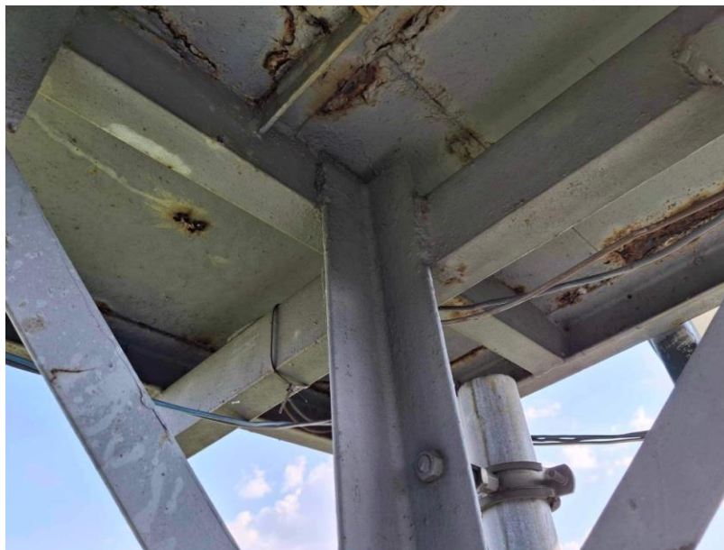
Fot. 22 – Kabina obserwacyjna - spód podłogi
