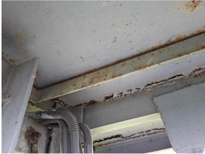
Fot. 23 – Kabina obserwacyjna - spód podłogi
