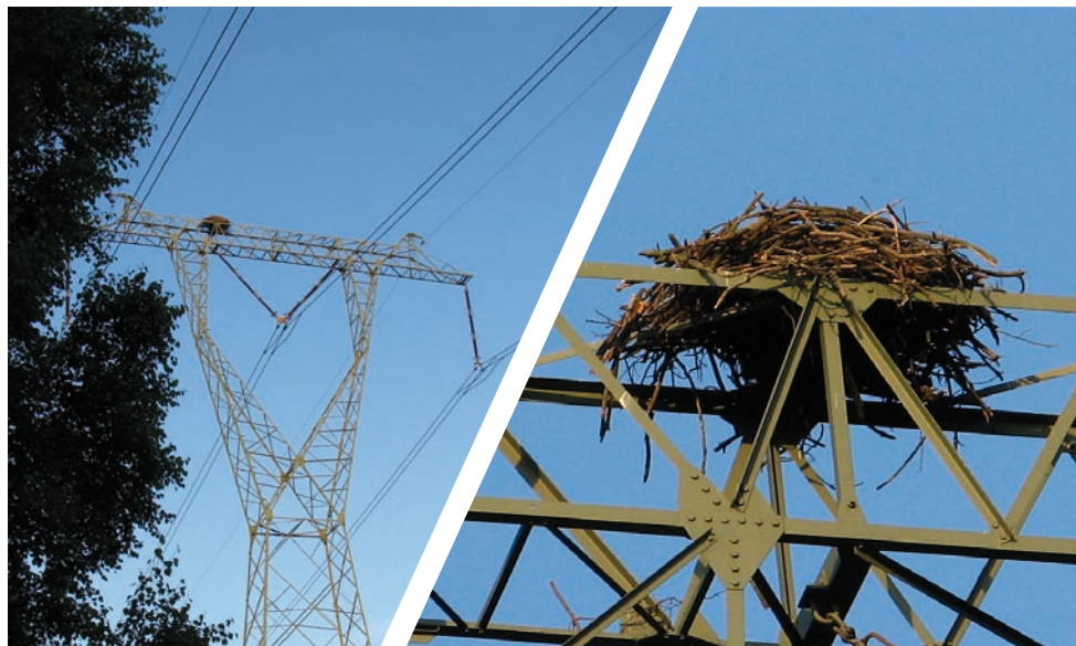
■ Stanowisko lęgowe rybołowa na słupie traktacji wysokiego napięcia, województwo lubuskie, czerwiec 2012 r.
