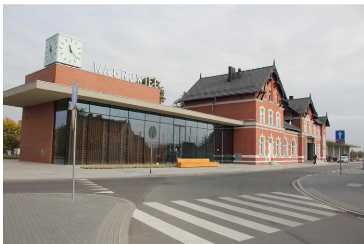
Dworzec kolejowy w Wągrowcu po modernizacji.
