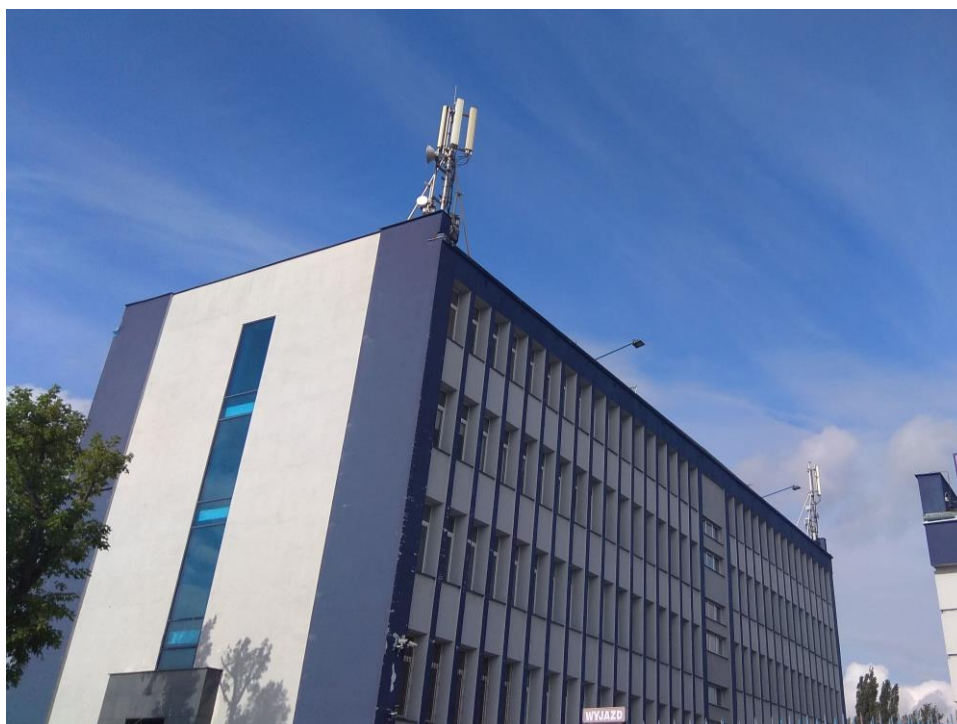
Fot. 1: Widok anten stacji bazowej ID: LOD1106_A, zlokalizowanej pod adresem: ul. Puszkina 80, 92-516 Łódź
