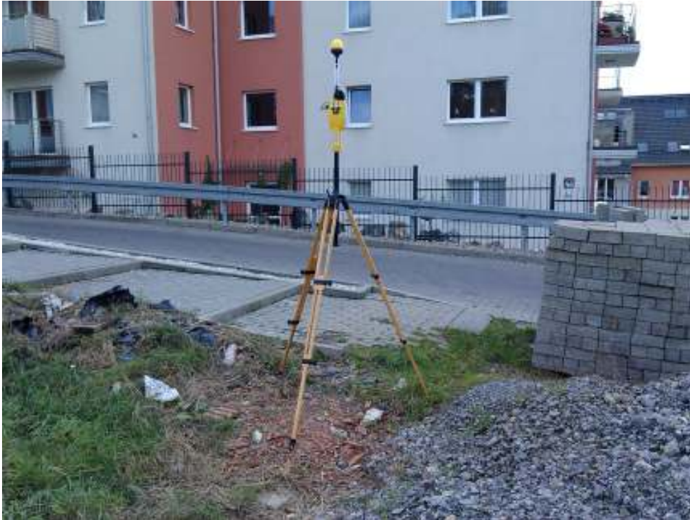
Fot. 1. Rejon badań, widok w kierunku południowym
