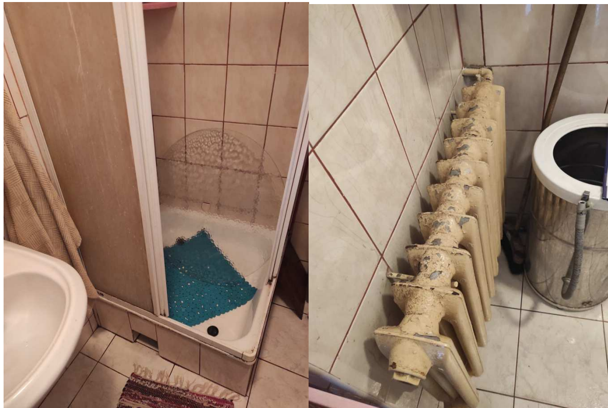
Rys. 1. wyeksploatowana armatura łazienkowa oraz okładziny ściennie i podłogowe
