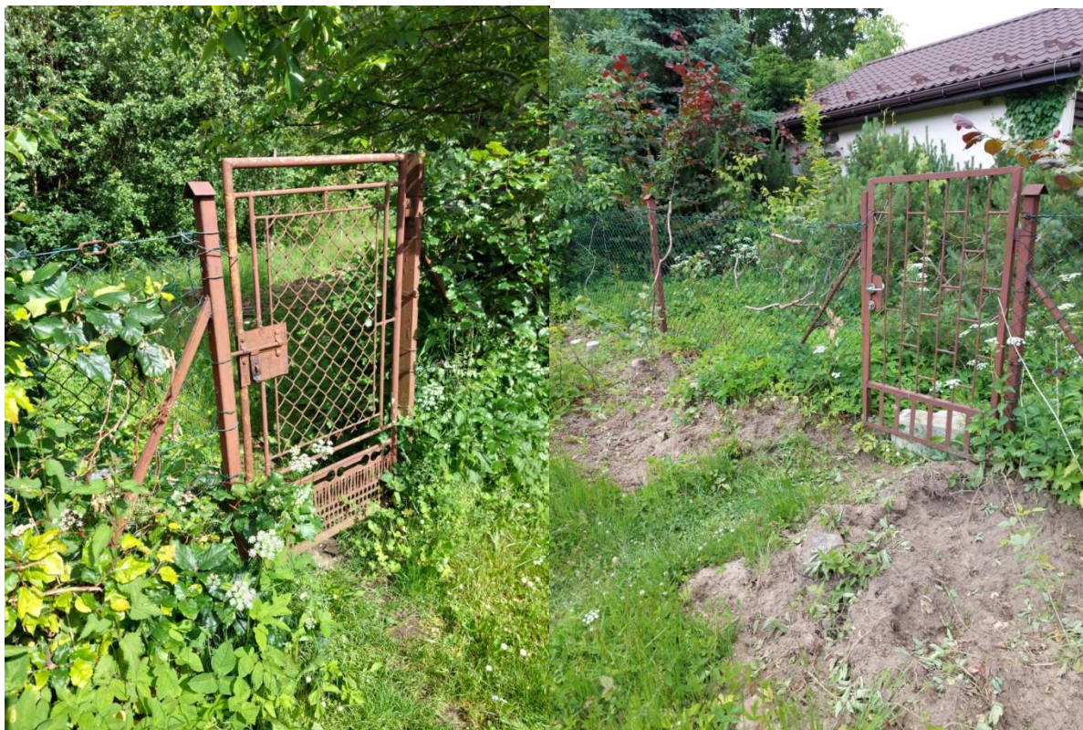
Rys. 2. wyeksploatowane ogrodzenie z siatki i furtki
