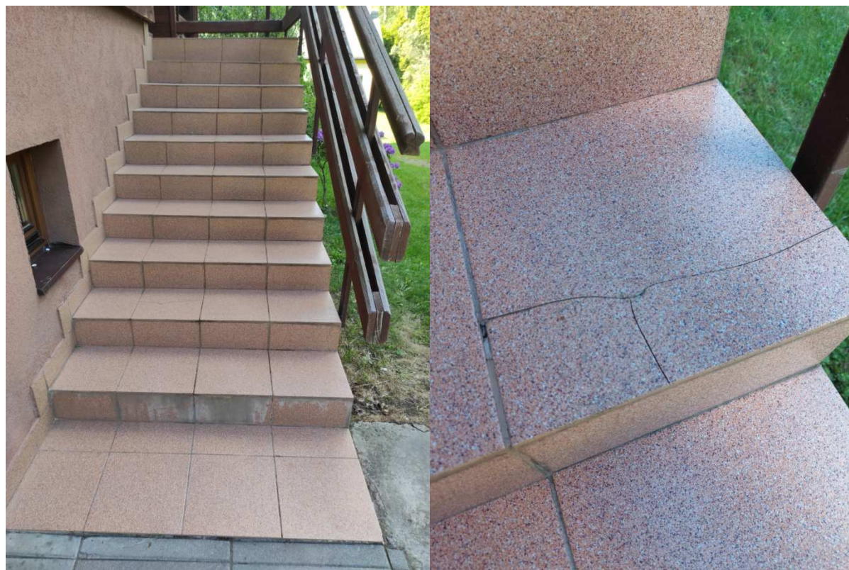
Rys. 1. wyeksploatowana i uszkodzona okładzina schodów wejściowych
