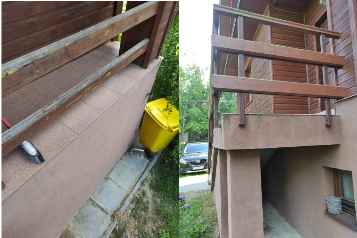
Rys. 2. wyeksploatowana okładzina tarasu przy schodach wejściowych oraz uszkodzona i wyeksploatowana barierka schodów wejściowych i tarasu
