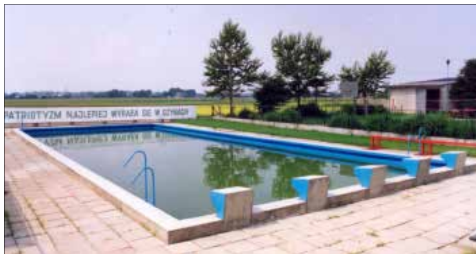
Na działce znalazło się także miejsce na wykonanie zbiornika przeciwpożarowego pełniącego funkcję basenu.
