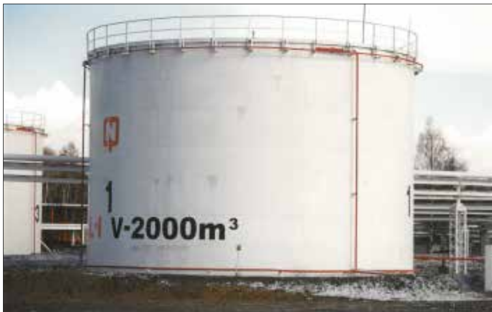
Zakład Gospodarki Produktami Naftowymi nr 12 (CPN), w którym funkcjonowała Zakładowa Zawodowa Straż Pożarna.
