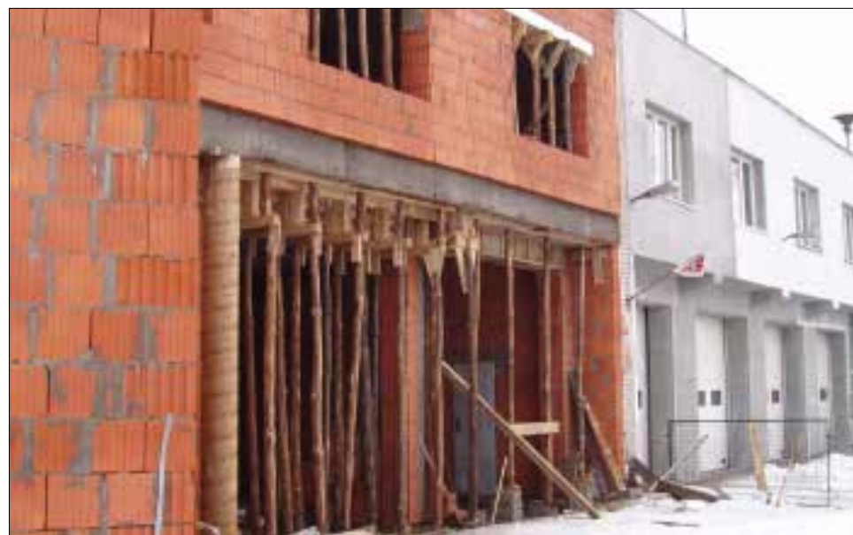
Dobudowana, w stanie surowym, nowa część budynku Komendy Powiatowej PSP w Koluszkach.
