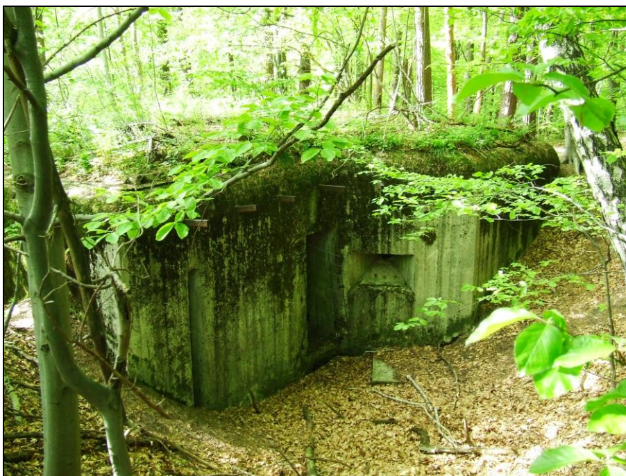
Fot. 11. Bunkier z sowieckich umocnień Linii Mołotowa
