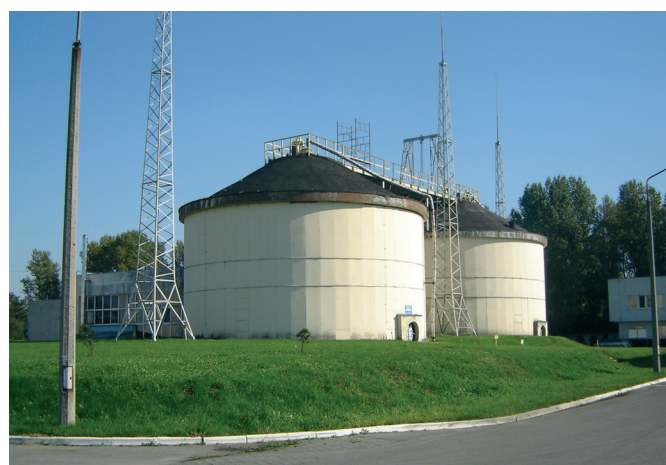
Fot. 4. Komory fermentacyjne w oczyszczalni ścieków „Centrum” w Dąbrowie Górniczej (archiwum PWiK Sp. z o.o.)
