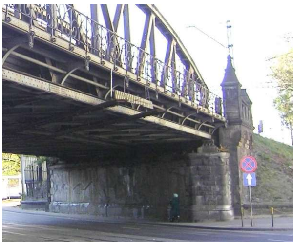
Rys. 6.2.1.1. Przykłady ukształtowania przyczółków masywnych
