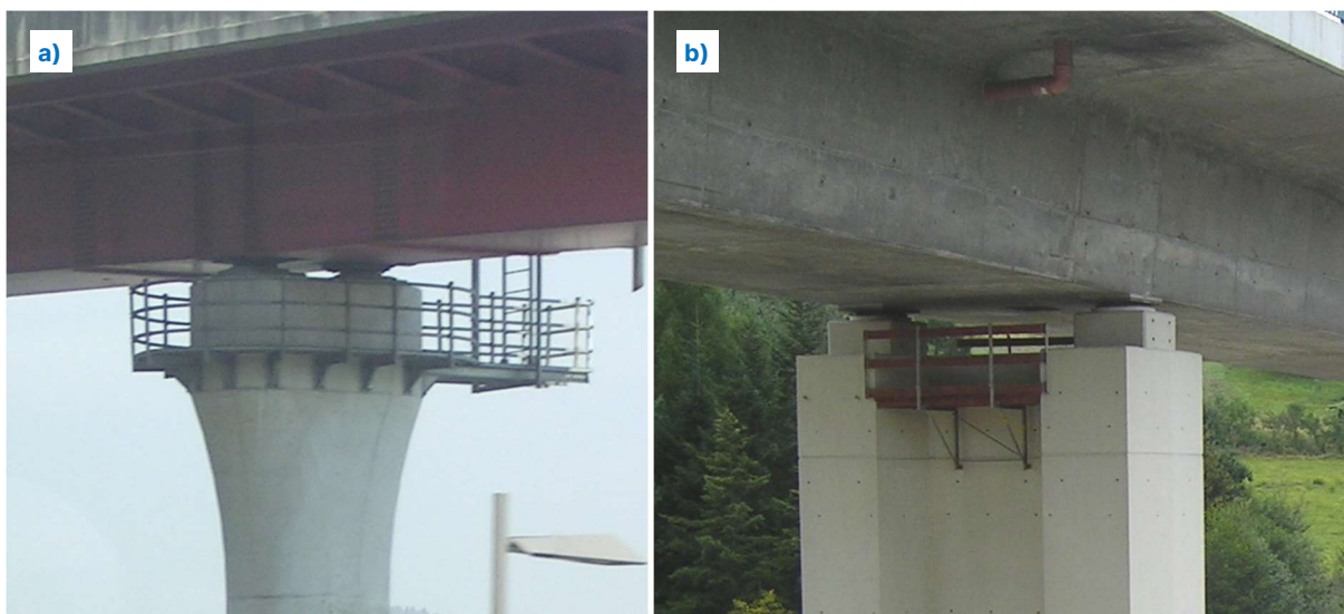
Rys. 9.4.1. Przykłady pomostów zlokalizowanych w obrębie głowicy filara: a) rozwiązanie zalecane – swobodny dostęp do głowicy filara; b) rozwiązanie niezalecane – ograniczony dostęp do głowicy filara
