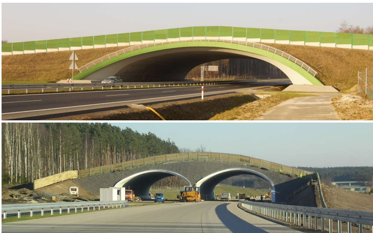
Rys. 7.2.1.1. Przykłady obiektów mostowych niewymagających stosowania płyt przejściowych
