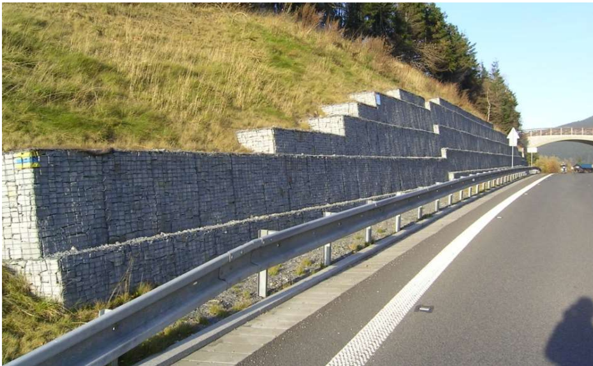
Rys. 4.7.4.1. Ściana oporowa z gabionów
