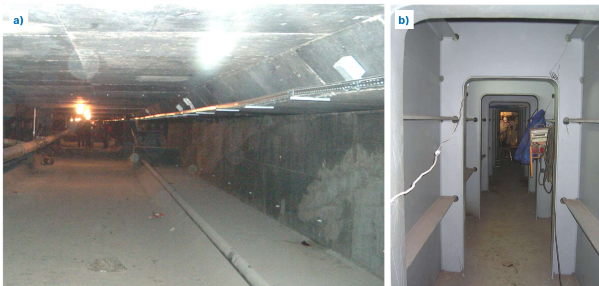
Rys. 9.3.1. Wnętrze korytarza: a) w dźwigarze skrzynkowym wiaduktu belkowego; b) w ryglu pylonu mostu podwieszanego
