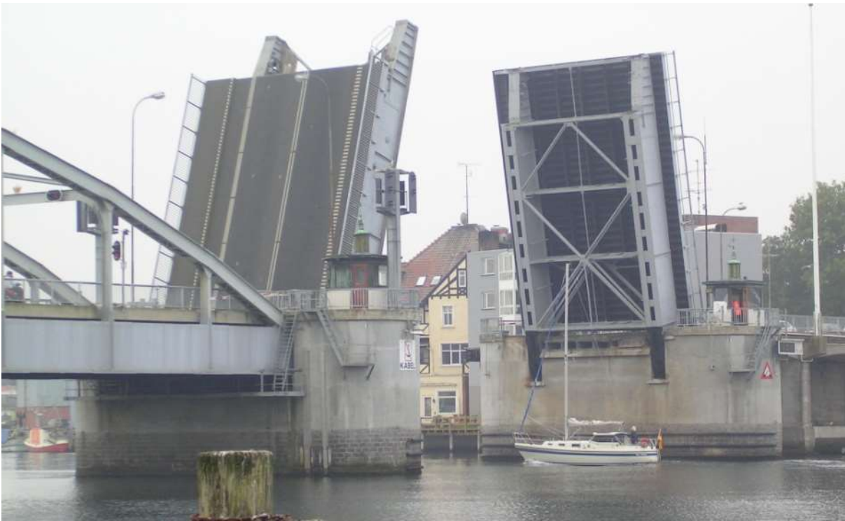
Rys. 4.2.1. Ruchomy most zwodzony
