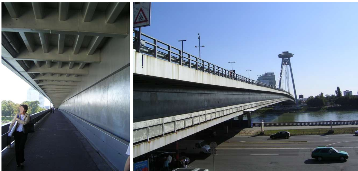
Rys. 5.1.1.1. Droga dla pieszych zlokalizowana poniżej poziomu jezdni na dużym moście podwieszonym
