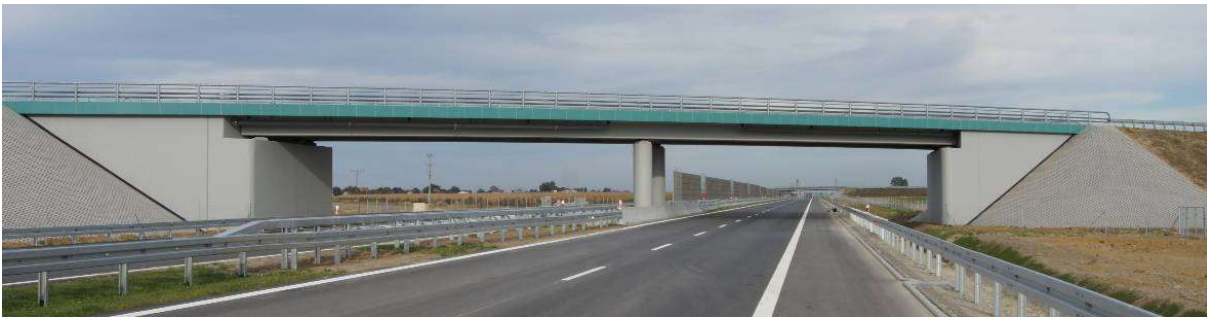
Rys. 4.9.1.1. Przykład poprawnie dobranej kolorystyki obiektu mostowego
