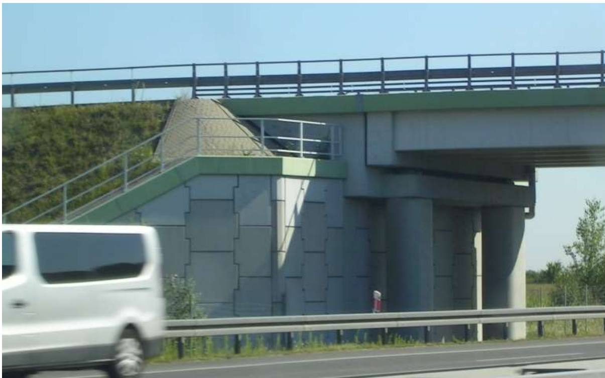
Rys. 4.7.3.1. Ściana z gruntu zbrojonego zlokalizowana za podporą słupową
