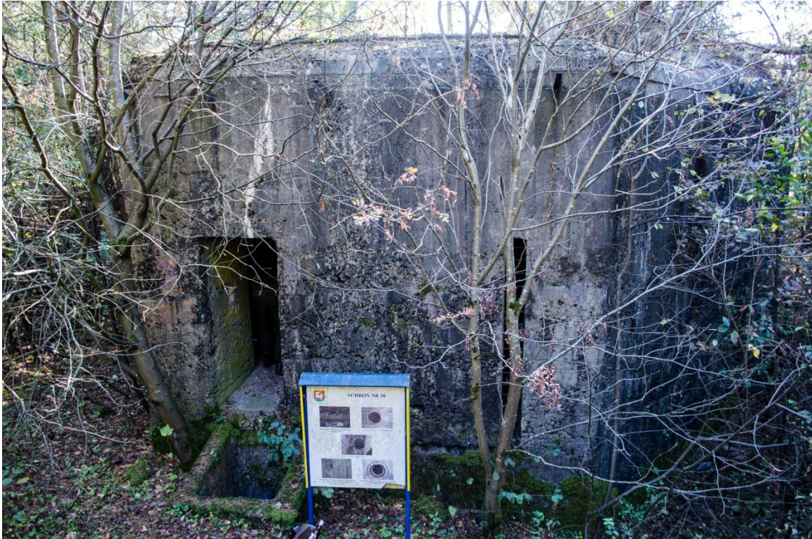
Ryc. 17. Schron Brzeskiego Rejonu Umocnieniowego oddz.413g (fot. M. Aniśko)
