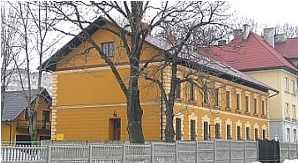
Rys. 14. Dom Samotnej Matki i Interwencji Kryzysowej w Rzeszowie.
