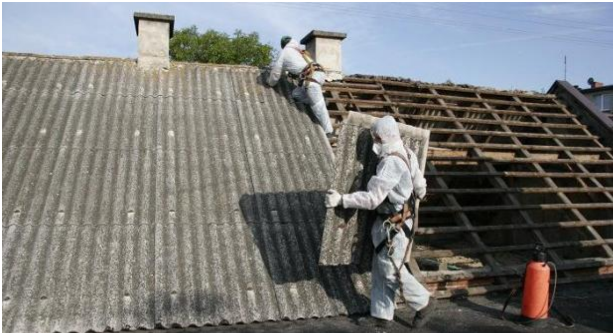
Rys. 10. Usuwanie płyt azbestowych z dachu budynku.
