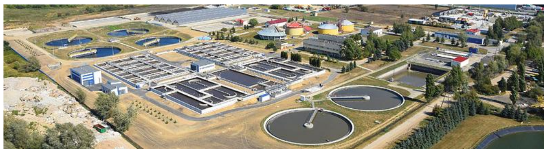
Rys. 12. Wodociąg komunalny należący do MPWiK w Rzeszowie.
