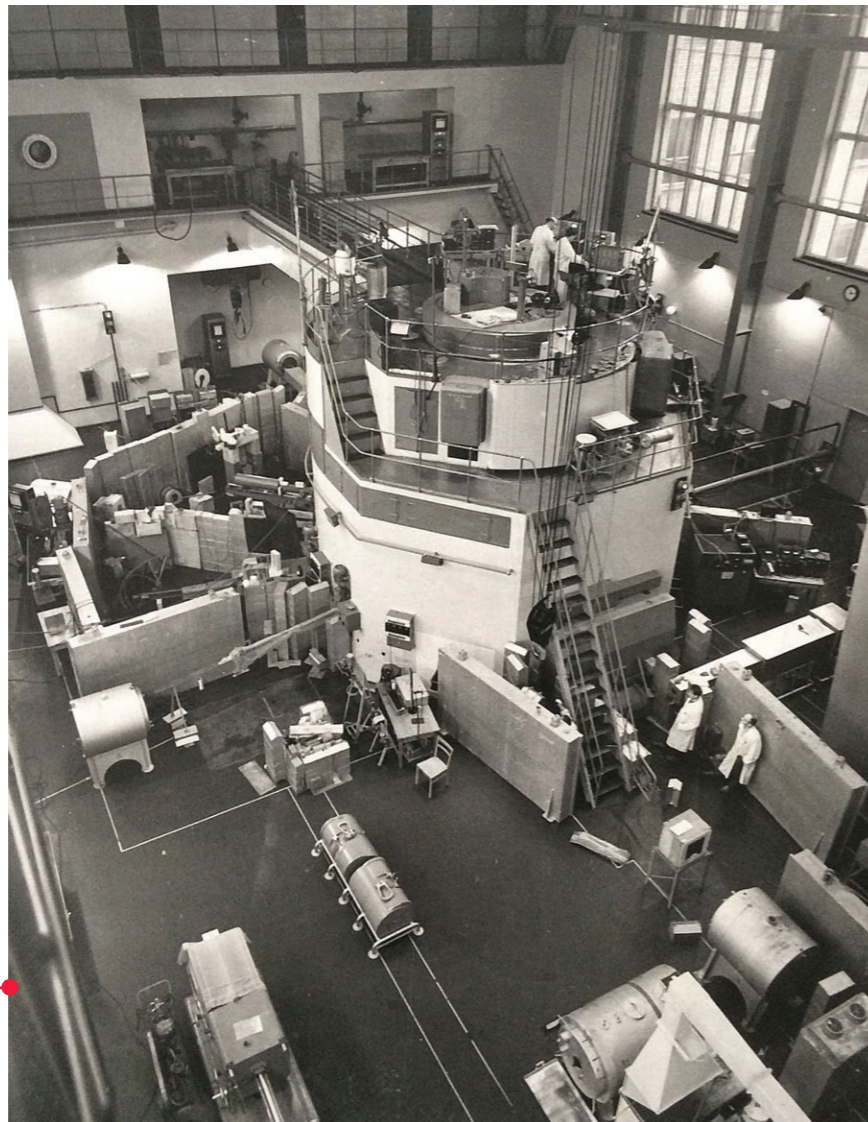
Widok hali reaktora EWA ok. 1965 r. w dawnym Instytucie Badań Jądrowych (obecnie w Zakładzie Unieszkodliwiania Odpadów Promieniotwórczych) w Świerku
