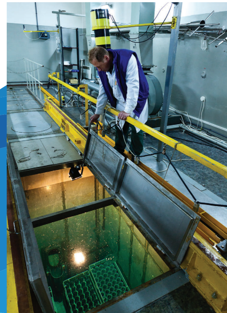
Przechowalnik nr 19A wypalonego paliwa jądrowego w Zakładzie Unieszkodliwiania Odpadów Promieniotwórczych
