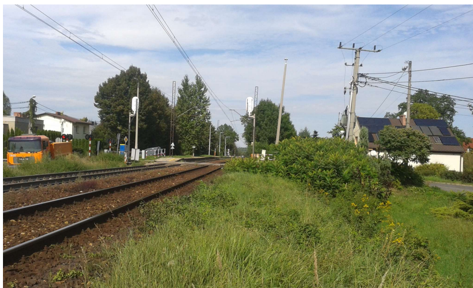
Fot. 3. Przyszowice, RB1. Linia kolejowa nr 149 w kierunku Zabrze.
