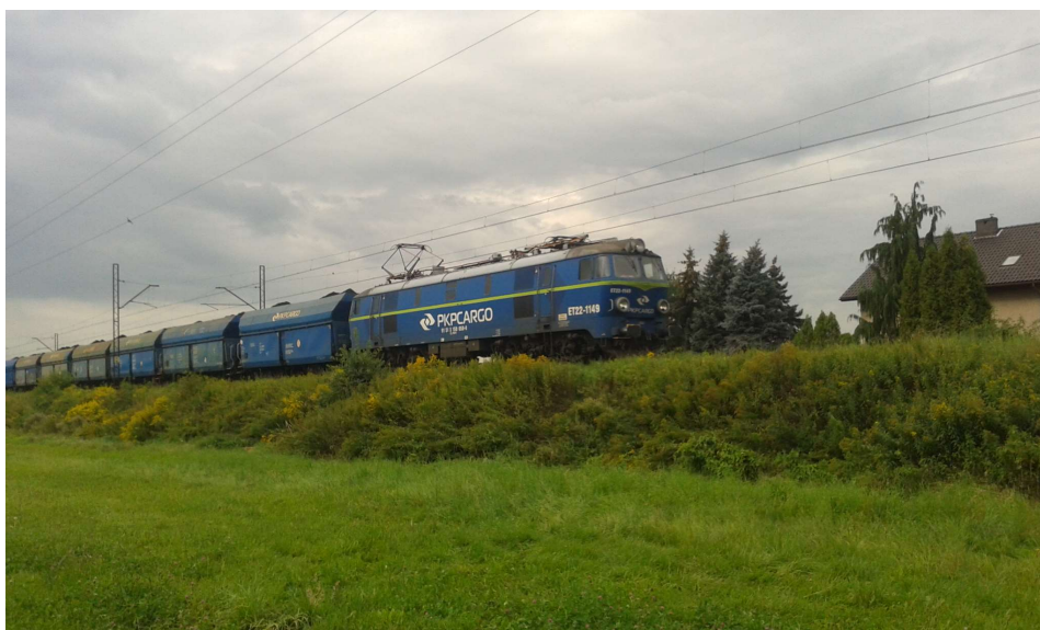
Fot. 2. Przyszowice, RB1. Linia kolejowa nr 149 w kierunku Knurowa.
