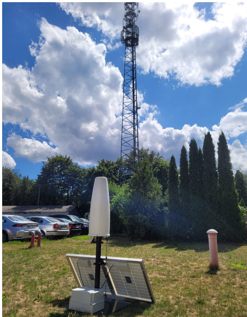
Rys. 3 Miejsce montażu SELMS PEM – TBS Zieleń Miejska w Pruszkowie – widok na SBTK
