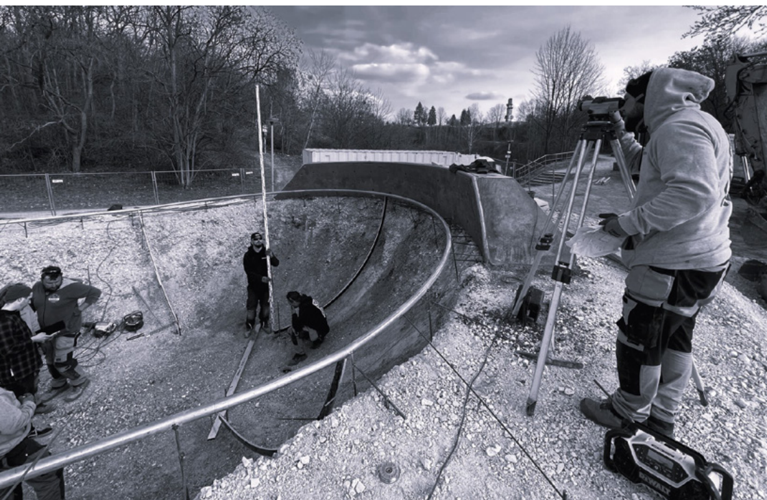
Fot.6.2.1 Kontrola budowy
