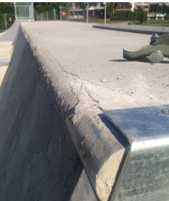
Fot.6.7.8 Wystające ostre krawędzie oraz osadzenie Copingu niezgodne z normą ze zburzonego skateparku w Tychach
