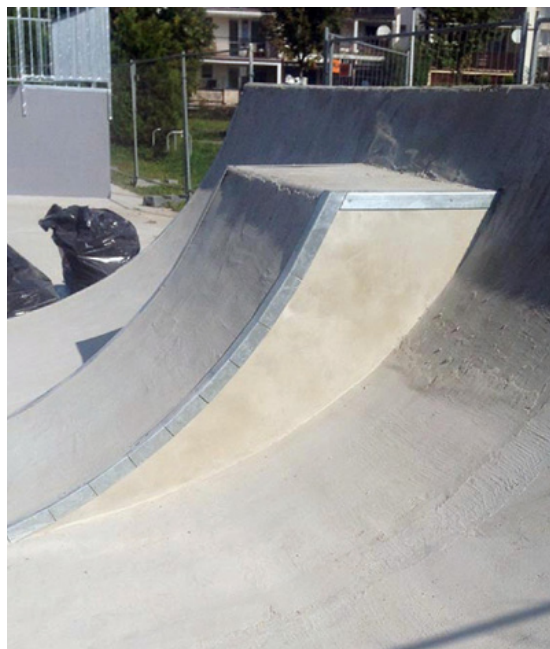
Fot.6.7.8 Wystające ostre krawędzie oraz osadzenie Copingu niezgodne z normą ze zburzonego skateparku w Tychach
