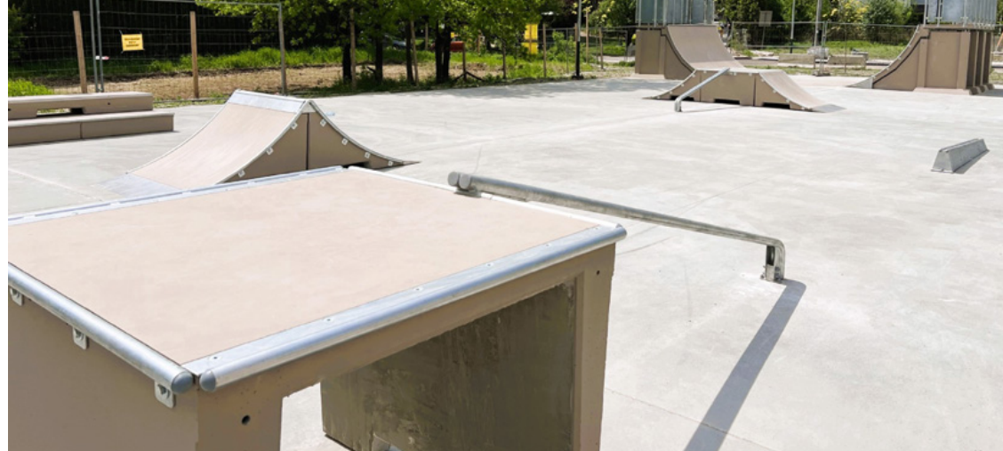
Fot.3.3.2 Przykład skateparku wykonanego z prefabrykatów betonowych w Krakowie
