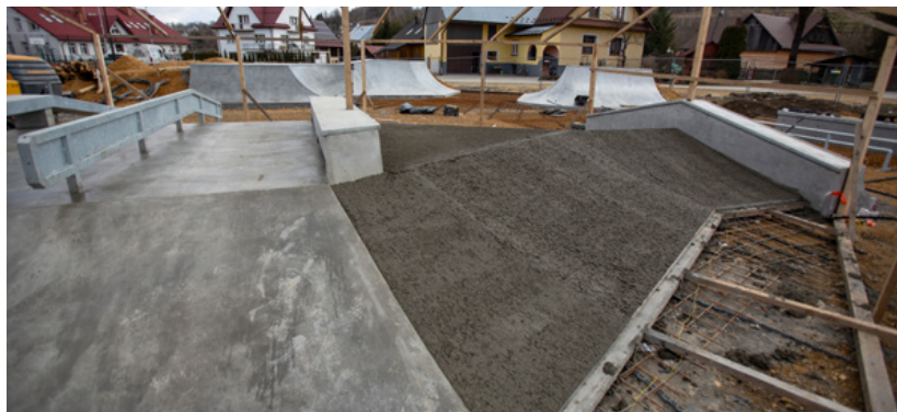
Fot.6.6.2 Budowa skateparku w Krakowie przy ul. Kąpielowej Fot.6.6.3 Szalunki na budowie skateparku w Bystrej Podhalańskiej
