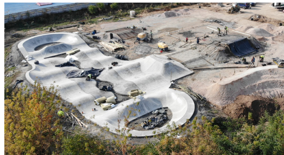
Fot.6.1.1 Prace nad skateparkiem w Mińsku Mazowieckim
