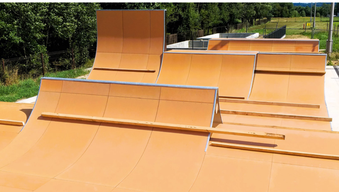
Fot. 7.5.1 Montaż skateparku modułowego
