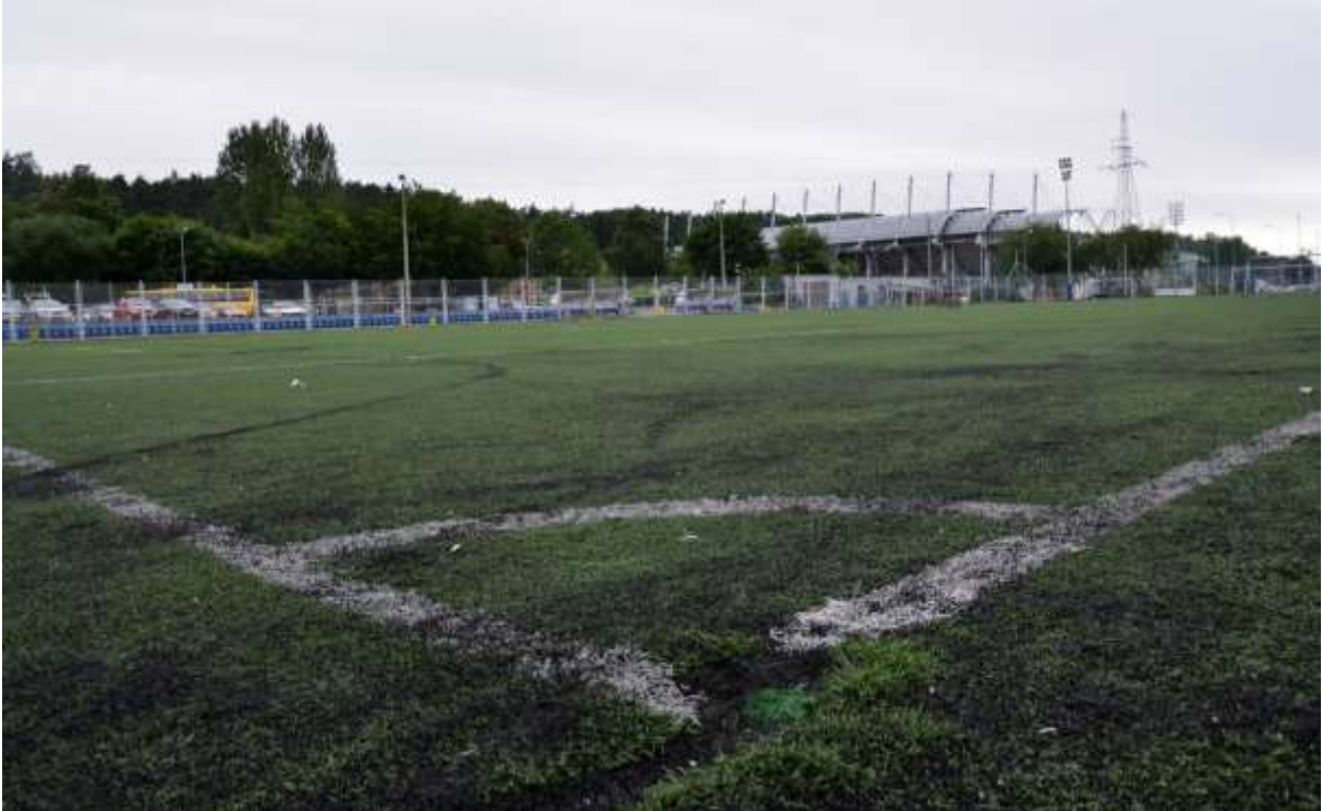
Fot. 10 – boisko Gdynińskiego Ośrodka Sportu i Rekreacji przed remontem.
