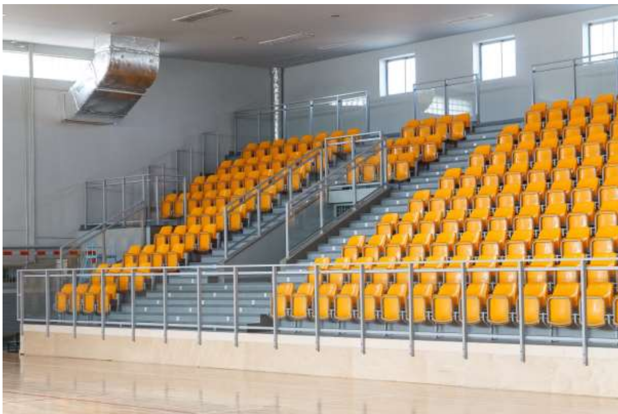
Fot. 7 - Hala w Skawinie po remoncie.
