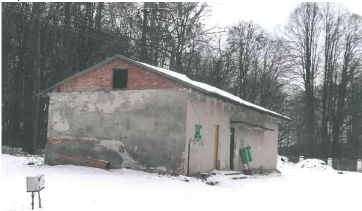
Fot. 26 – budynek zaplecza sanitarno-szatniowego w Ulanowie przed przebudową.
