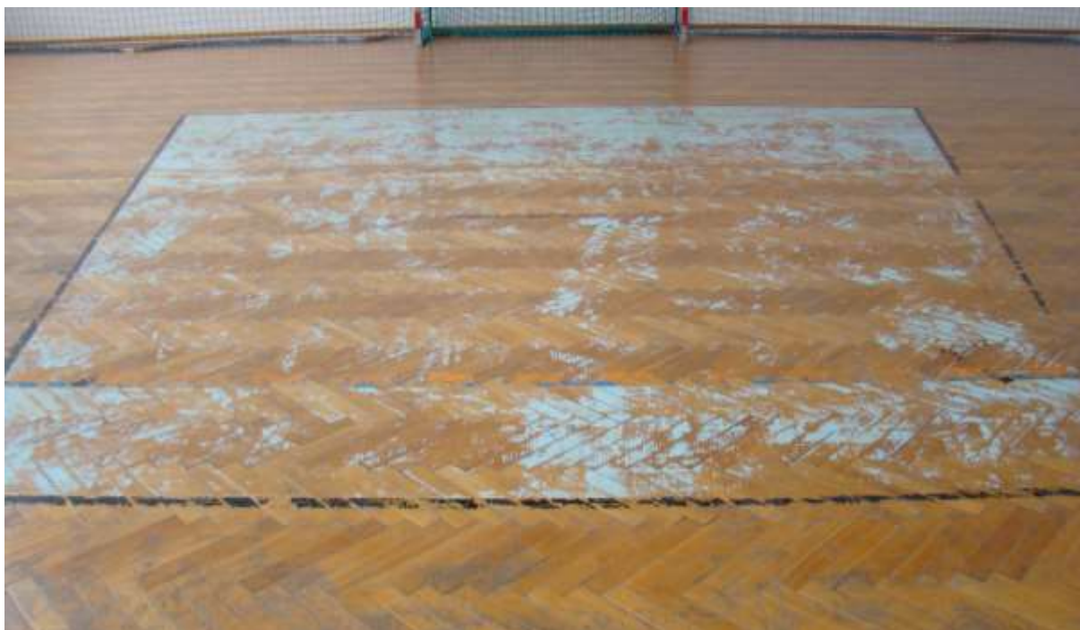
Fot. 8 – Sala gimnastyczna w Zespole Szkół w Starych Żukowicach przed remontem.
