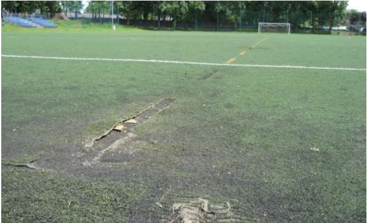
Fot. 12 – boisko MORiS w Chorzowie przed remontem.
