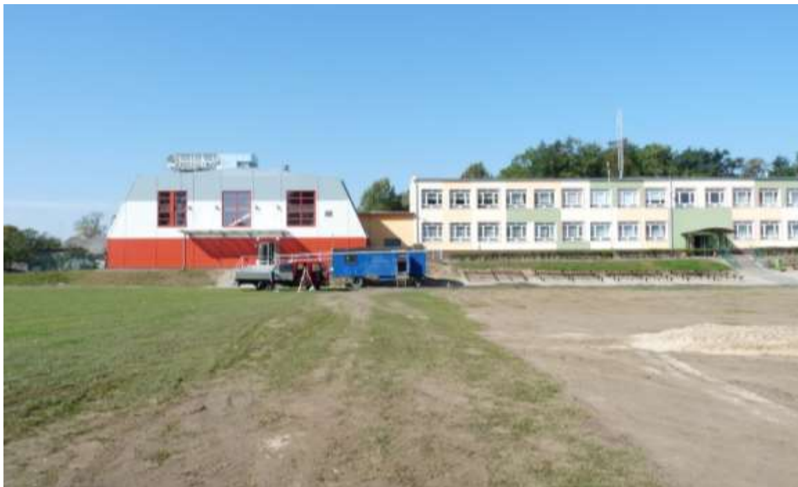
Fot. 1 – Boisko przy zespole szkolnym przed przebudową.
