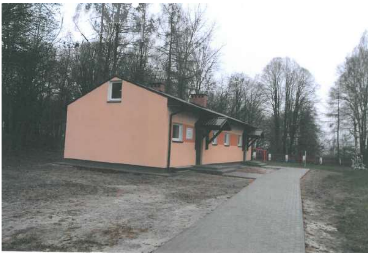
Fot. 27 – budynek zaplecza sanitarno-szatniowego w Ulanowie po przebudowie.
