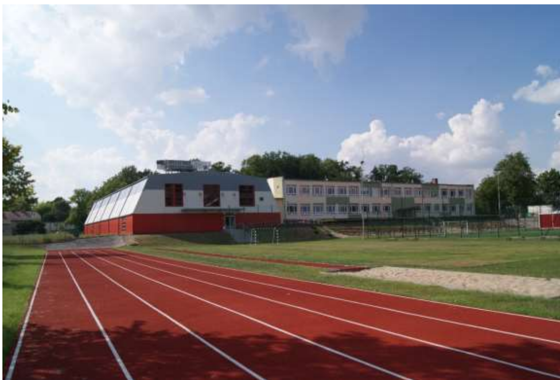
Fot. 2 – Boisko przy zespole szkolnym po przebudowie.
