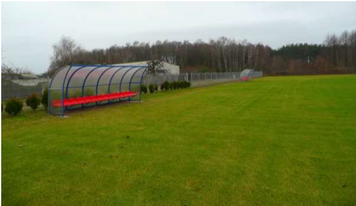
Fot. 15 - boisko sportowe w Zbąszyniu po modernizacji.
