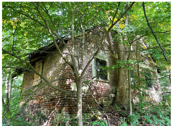
widok na obiekt – widok na elewację wschodnią oraz południową od stron wnętrza działki
