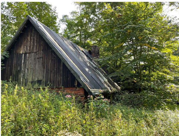
widok na obiekt – elewacja zachodnia od strony wnętrza działki, widok na fragment elewacji południowej
