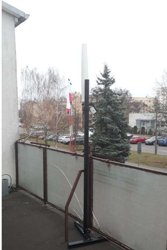
Rys. 2 Miejsce montażu SMS PEM – Zespół Szkół nr 5, Bydgoszcz
