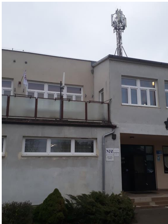
Rys. 3 Miejsce montażu SMS PEM – Zespół Szkół nr 5, Bydgoszcz – widok z poziomu gruntu
