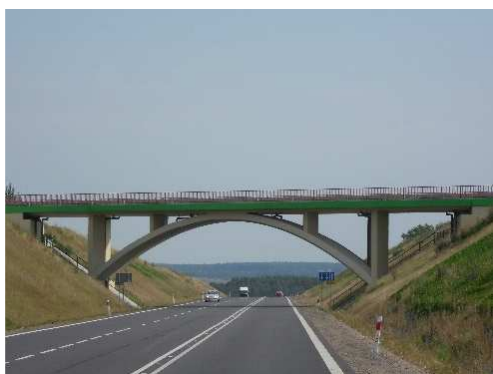
Rys. 3.184. Dźwigar łukowy w przęśle centralnym oraz dźwigary płytowe w przęsłach skrajnych niewykazujące uszkodzeń
