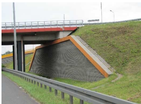
Rys. 3.317. Konstrukcja oporowa pod wspornikiem ustroju nośnego przęsła w bardzo dobrym stanie
