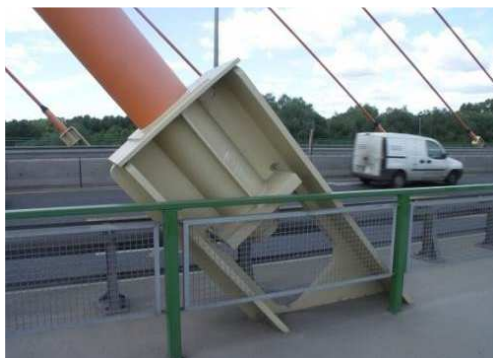
Rys. 3.345. Zakotwienie wanty w dobrym stanie
