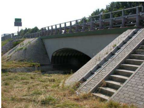
Rys. 3.83. Gzyms na ścianie czołowej konstrukcji gruntowo-powłokowej bez uszkodzeń, w dobrym stanie technicznym
