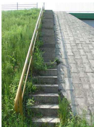
Rys. 3.2. Wegetacja roślin na schodach nieprzekraczająca 10% powierzchni
