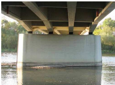
Rys. 3.267. Filar bez uszkodzeń
