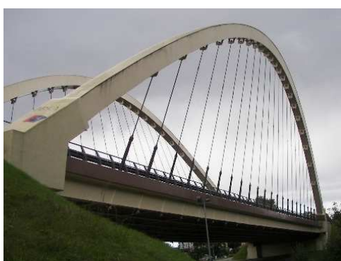
Rys. 3.365. Wieszaki w dobrym stanie technicznym
