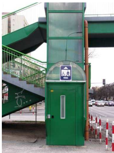
Rys. 3.379. Winda sprawna, bez widocznych uszkodzeń zewnętrznych
