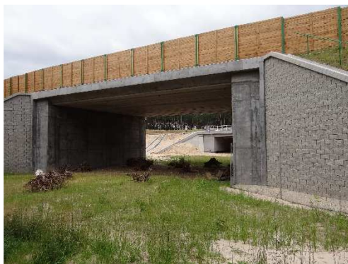
Rys. 3.304. Teren pod przejściem dolnym dla dużych zwierząt bez uszkodzeń, właściwie utrzymany Kod uszkodzenia: - Ocena: 5
