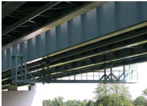
Rys. 3.381. Wózek rewizyjny w bardzo dobrym stanie
