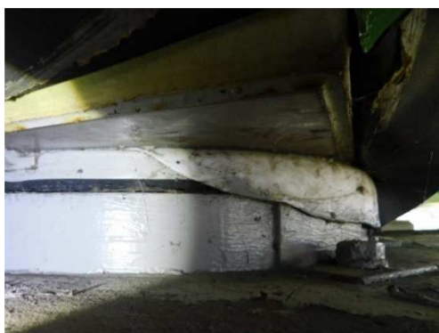
Rys. 3.214. Wysunięcie arkusza teflonu (PTFE), istotna zmiana oporów przesuwu łożyska
