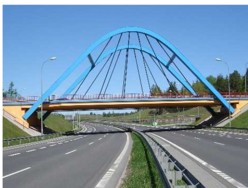
Rys. 3.199. Stalowe dźwigary łukowe wraz ze stężeniami i wieszakami niewykazujące uszkodzeń
