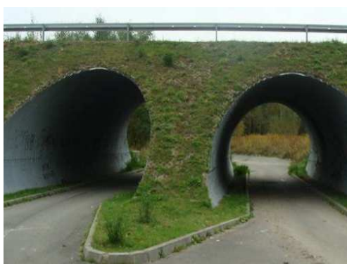
Rys. 3.293. Wiadukt gruntowo-powłokowy dwutorowy o przekroju zamkniętym – filar (fundament) bez uszkodzeń
