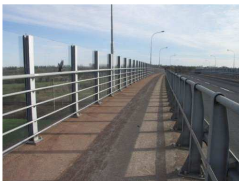
Rys. 3.327. Ekran przeciwhałasowy w dobrym stanie
