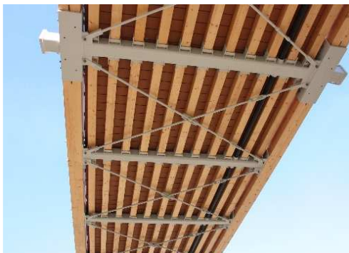
Rys. 3.139. Drewniane elementy pomostu nie wykazują uszkodzeń
