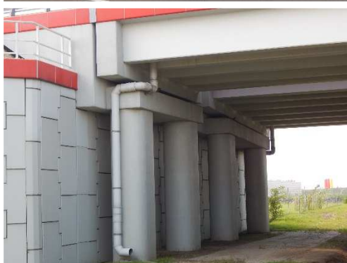
Rys. 3.261. Przyczółek dwudzielny, część przednia (ramownica z betonu monolitycznego) oraz część tylna (z gruntu zbrojonego) niewykazujące uszkodzeń
