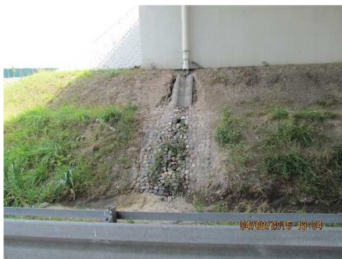
Rys. 3.103. Uszkodzenie ścieku skarpowego – ubytki i przemieszczenia elementów obrukowania, brak spoinowania, wypłukanie gruntu, wegetacja roślin
