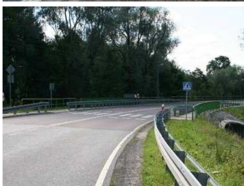
Rys. 3.24. Brak uszkodzeń na dojazdach do obiektu mostowego o konstrukcji gruntowo-powłokowej
