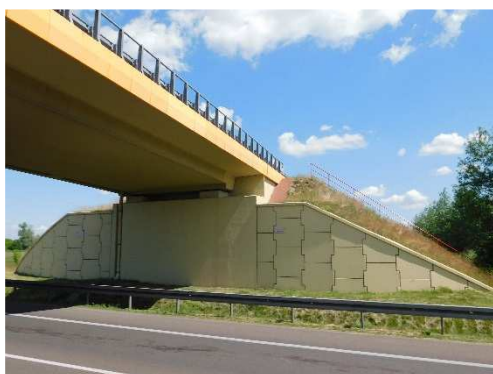
Rys. 3.260. Korpus przyczółka niewykazujący uszkodzeń
