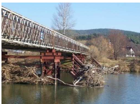
Rys. 3.297. Liczne zanieczyszczenia gromadzące się przy filarach, utrudniające spływ wody i kry lodowej
