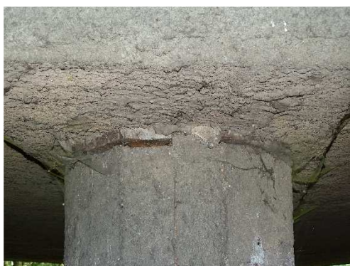
Rys. 3.228. Przegubowe połączenie filara z płytową konstrukcją ustroju nośnego. Łożysko przegubowe betonowe z ograniczoną możliwością obrotu, elementy deskowania z okresu budowy ograniczają obrót przegubu
