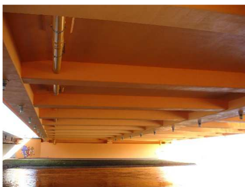
Rys. 3.132. Betonowa płyta pomostu oraz betonowe poprzecznice niewykazujące uszkodzeń
