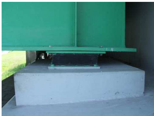
Rys. 3.211. Łożysko elastomerowe w dobrym stanie, położenie prawidłowe, adekwatne do temperatury otoczenia – fotografię wykonano w okresie wysokich temperatur (lipiec, temperatura otoczenia +25°C)
