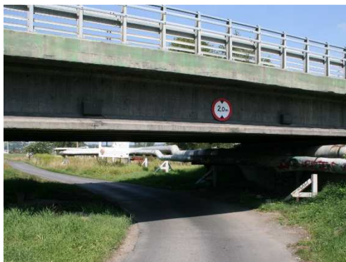
Rys. 4.9. Skrajnia pod obiektem o ograniczonej wysokości
