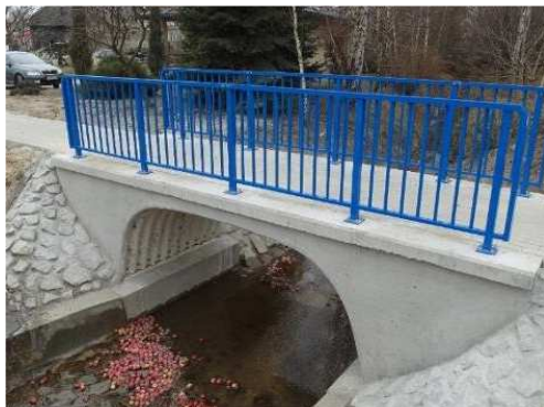
Rys. 3.68. Balustrada na kładce dla pieszych o konstrukcji gruntowo-powłokowej w bardzo dobrym stanie technicznym
