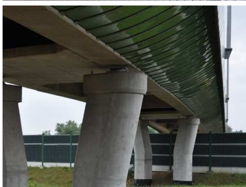
Rys. 3.71. Osłona boczna, pełniąca funkcję dekoracyjną/maskującą, w dobrym stanie (na elementach osłon widoczne refleksy świetlne)
