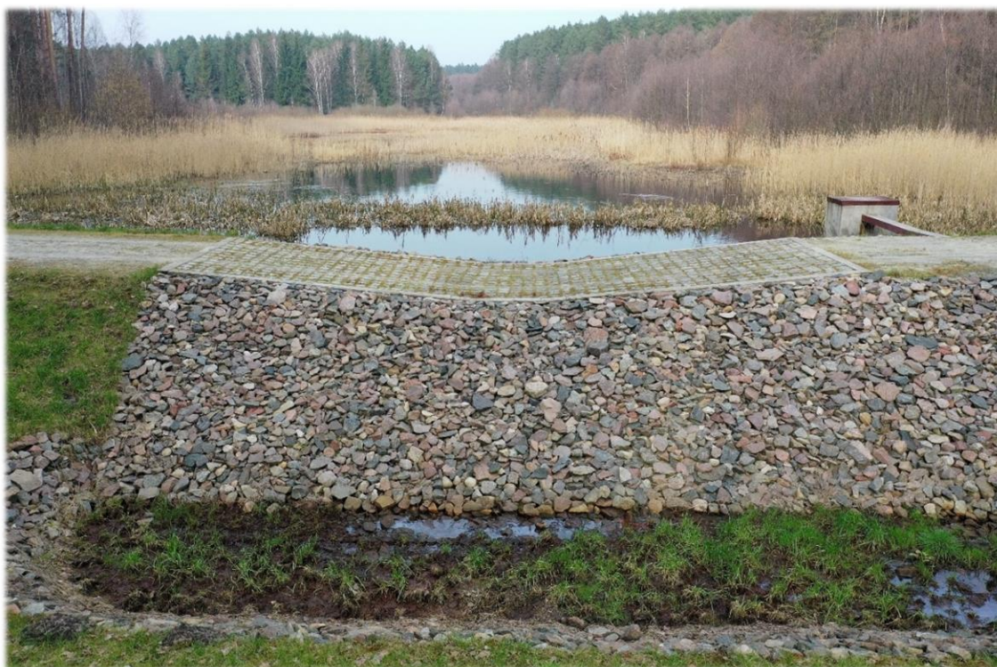
Fig. 20. Efekt prac w ramach projektu „Renowacja założeń małej retencji - Rynna Grodzisko” (fot. zasoby Nadleśnictwa Człopa).
