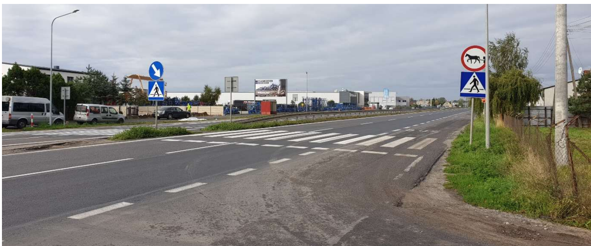
Zdjęcie 4 – przejście przez drogę dwujezdniową, brak dostatecznego oświetlenia, możliwość rozwijania dużych prędkości przed przejściem mała postrzegalność przejścia, brak bezpiecznych dojeżdż (chodników), błędy w oznakowaniu.
