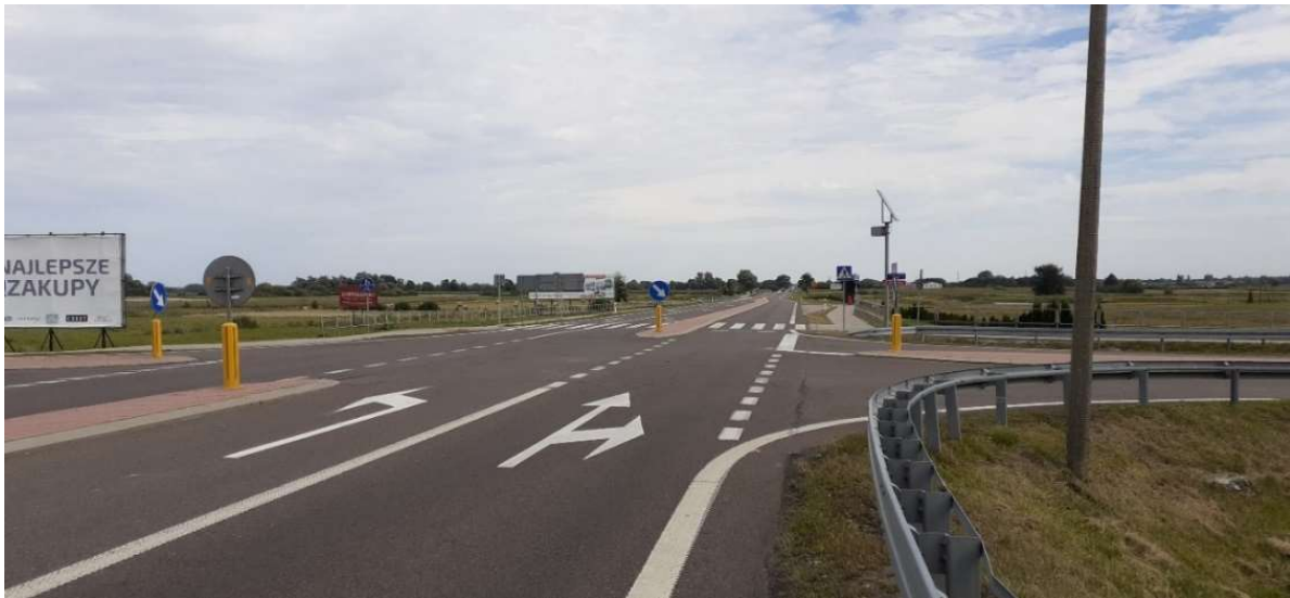
Zdjęcie 6 - Słaba postrzegalność przejścia dla pieszych. Niewidoczne oznakowanie (Brak znaku D-6 nad jezdnią). Brak doświetlenia przejścia oraz dojścia do przejścia, nie jest zapewniona odpowiednia dostrzegalność w porach ograniczonej widoczności (od zmierzchu do świtu). Przed przejściem dla pieszych brak elementów ostrzegawczych dla niewidomych i niedowidzących. Zbyt mała szerokość wyniesionego azylu w osi drogi (niechroniony pieszy).
