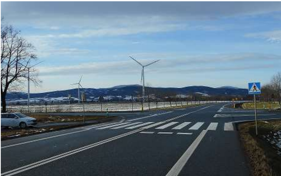
Zdjęcie 1 - brak oświetlenia, możliwość rozwijania dużych prędkości przed przejściem, brak dojść (chodników), słaba postrzalność miejsca przejścia, błędy w oznakowaniu.
