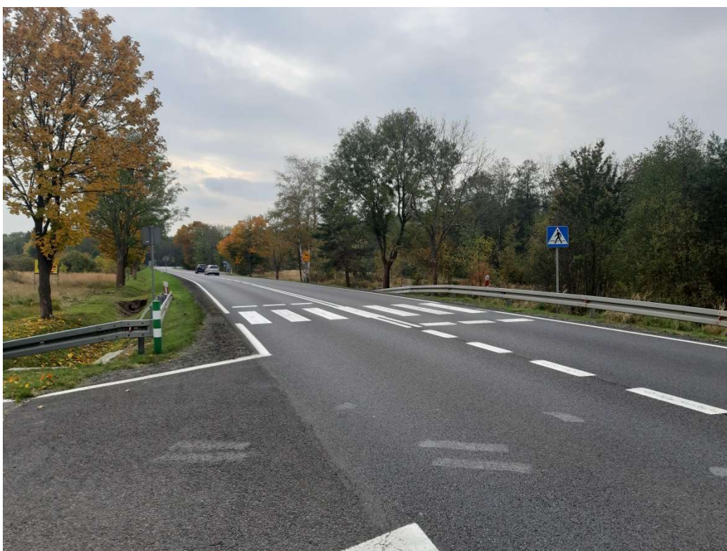
Zdjęcie 5 - Słaba postrzegalność przejścia dla pieszych. słabo widoczne oznakowanie ,brak doświetlenia przejścia, brak dojeżdż do przejścia (pieszy wprowadzany w bariery), ograniczenia widoczności, brak skutecznej redukcji prędkości.
