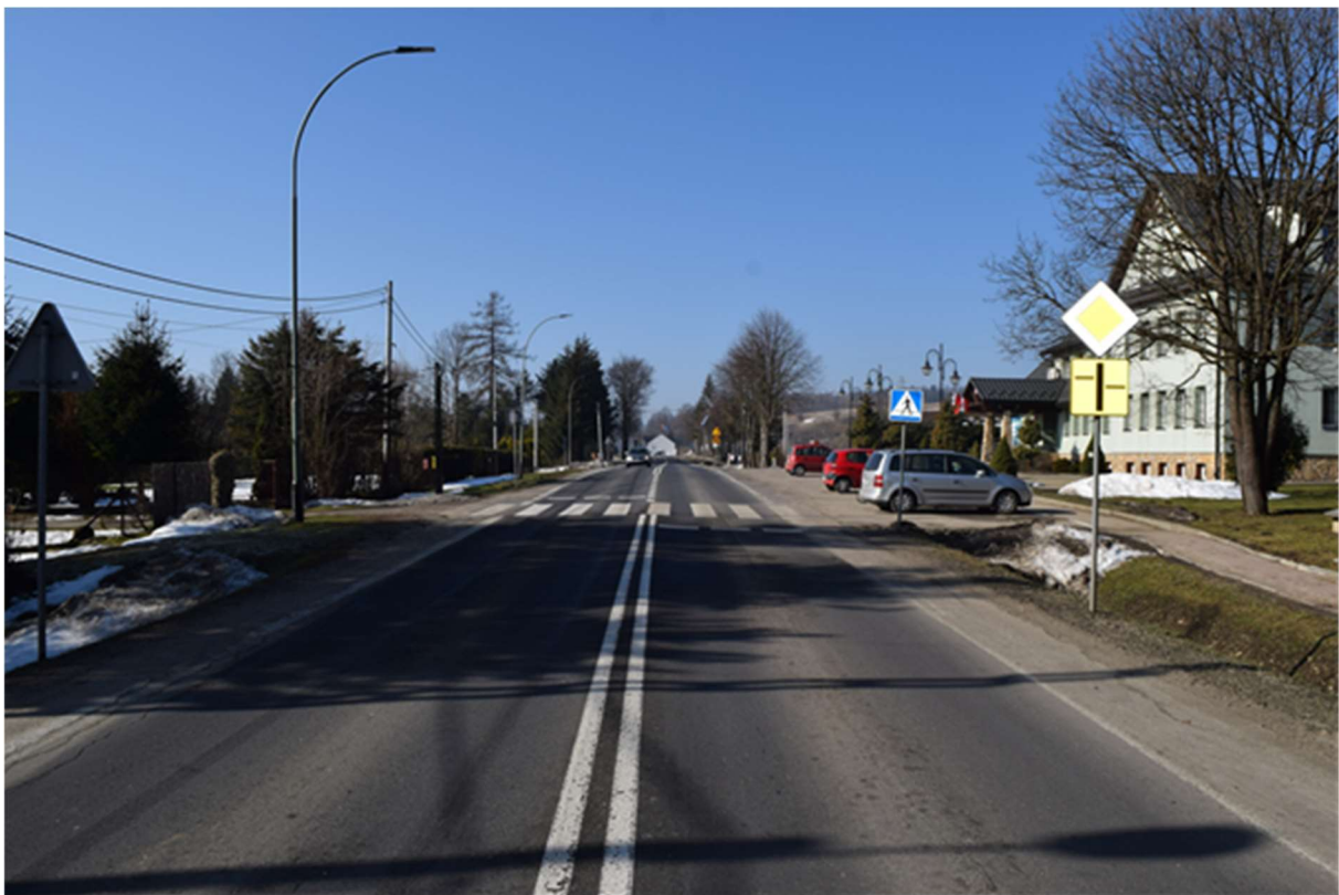
Zdjęcie 2 i 3 - brak właściwego oświetlenia, możliwość rozwijania dużych prędkości przed przejściem, brak dojeść (chodników), słaba postrzegalność miejsca przejścia, błędy w oznakowaniu, parkowanie w strefie przejścia.
