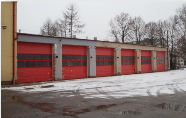
Fot. 59 KP PSP Chojnice.
