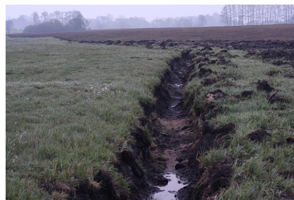
Nowe rowy melioracyjne pozbawione urządzeń zatrzymujących wodę
