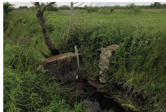
Stare rowy melioracyjne ze zniszczonymi urządzeniami piętrzącymi wodę
